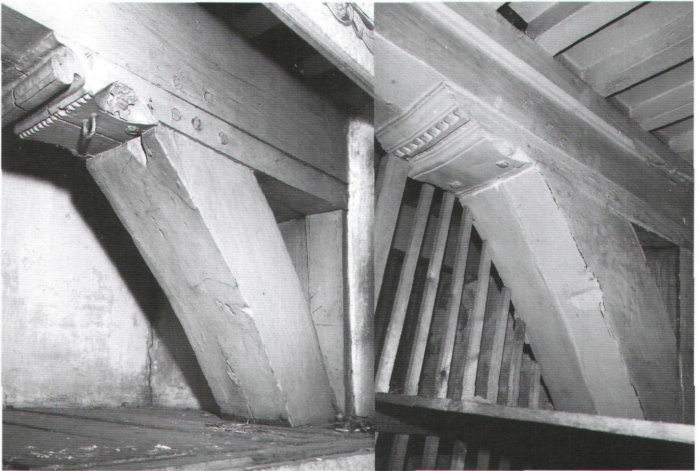
Afb. 11. Warmoesstraat 44, Amsterdam (links). Traditionele peerkraalprofilering aan het sleutelstuk, XVIa; Warmoesstraat 16, Amsterdam (rechts). Overgang naar de 'kroonlijstprofilering' aan het sleutelstuk, midden zestiende eeuw (foto's BMA)
