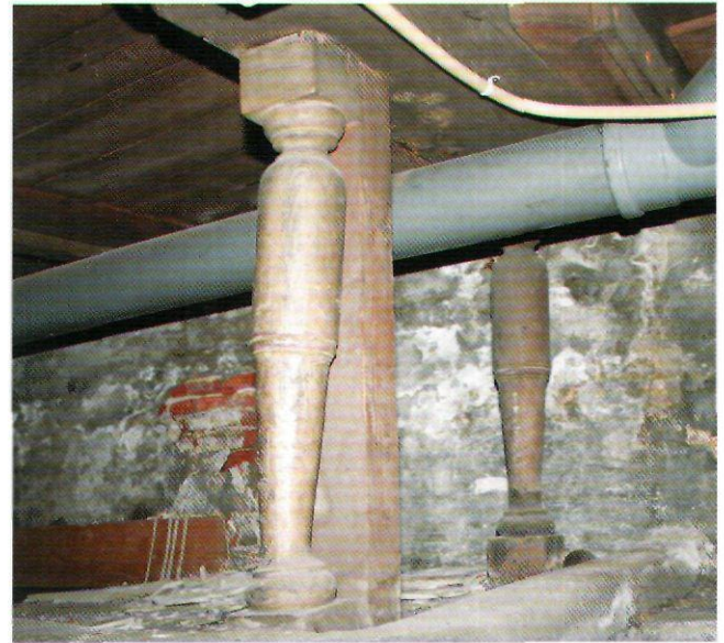
Afb. 15. Drijvende kelder Herengracht 354 Amsterdam, vastgezet met gedraaide stijlen (foto Dik de Roon 2004)
