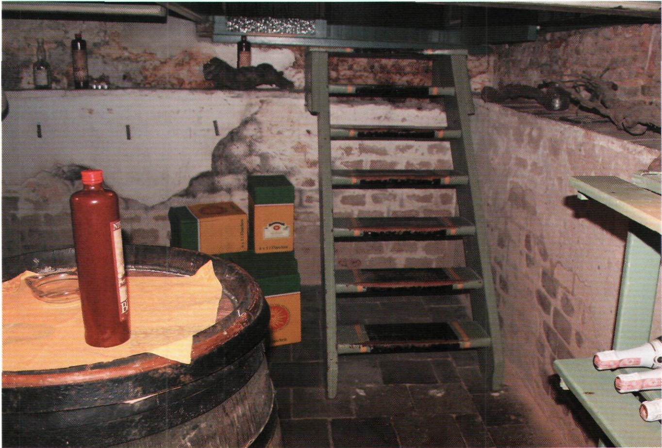
Afb. 10. Nog functionerende drijvende kelder Dorpsstraat 116 te Nieuwkoop (foto Dik de Roon 2005)
