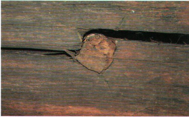
Afb. 8A. Sporen van houtvlotverbindingen in de Schreierstoren (BMA – Gabri van Tussenbroek)
