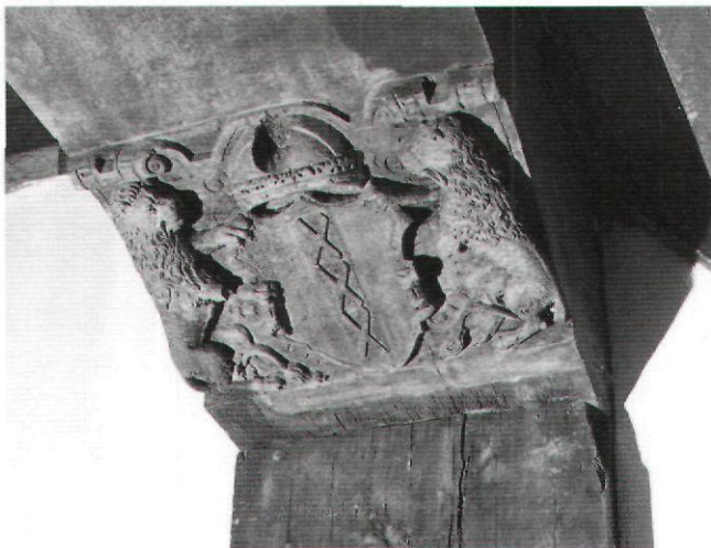
Afb. 13. Oudezijds Voorburgwal 78, Amsterdam. Korte balksleutel met het wapen van Amsterdam, tussen 1555-1583 (foto Han van Gool, BMA)
