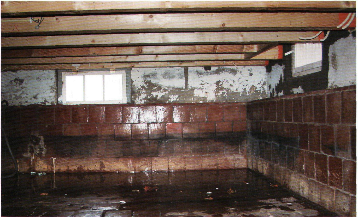
Afb. 17. Drijvende kelder in de Zeehoeve aan de Diemerzeedijk (foto Dik de Roon 2004)
