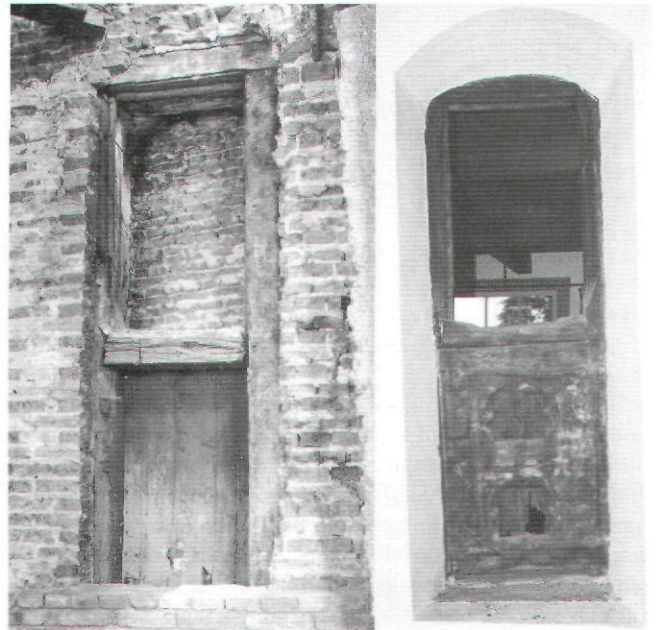
Afb. 19. Het houten kloosterkozijn dat tijdens de restauratie van de Schreierstoren tevoorschijn kwam. Buiten- en binnenzijde. Opname van september 1967 (BMA)
