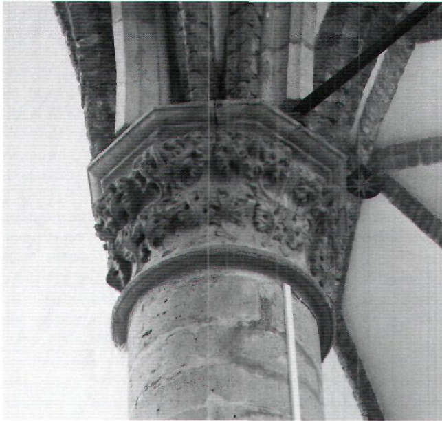
Afb. 7. Alkmaar, Sint-Laurenskerk, buiten de dekplaat uitstekende rib in een van de zijkapellen van het schip, 1470-ca. 1490 (foto auteur)
