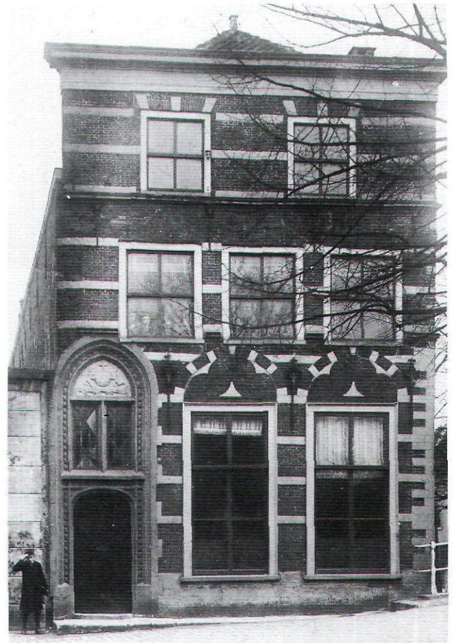
Afb. 8b. Verminkte voorgevel. Hoge benedenverdieping. Portaal uit Belgische groeven. Indeling vensterbogen door natuursteenstukken. Vrije vensterplaatsing (oude ansichtkaart)
