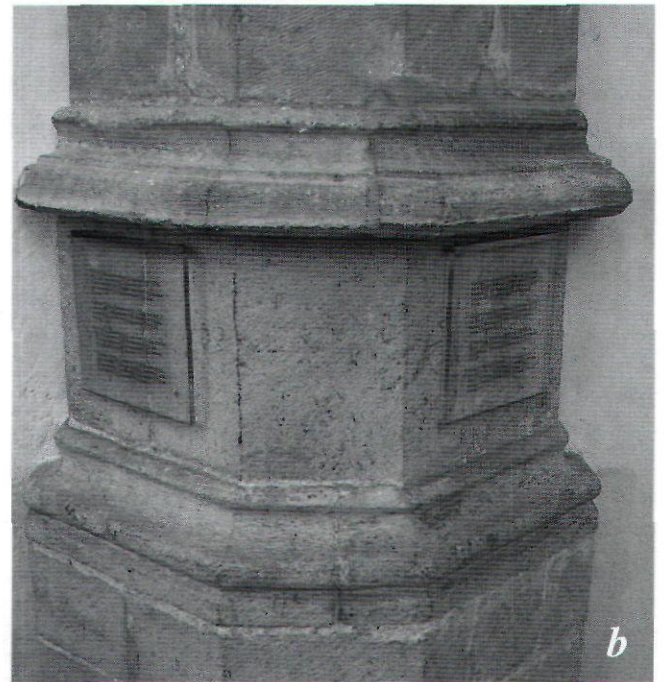
Afb. 15. a. Antwerpen, Sint-Jacobskerk, basement van een pijler in een zijkapel van het schip, Rombout II Keldermans, Domien de Waghemakere, ca. 1525; b. Breda, Onze-Lieve-Vrouwekerk, basement van een pijler in de kooromgang, Rombout II Keldermans(?), 1515-1540; (foto auteur)
