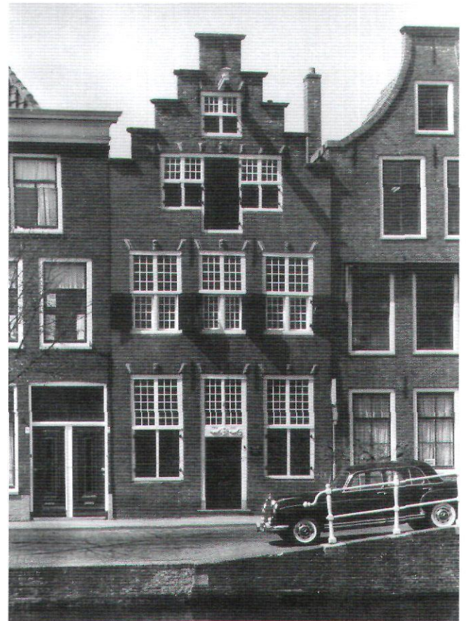
Afb. 2. Herengracht 82, voorgevel gedateerd 1660. De hijsdeur en -balk zijn een latere toevoeging (foto RdMz, foto- en tekeningenarchief)
