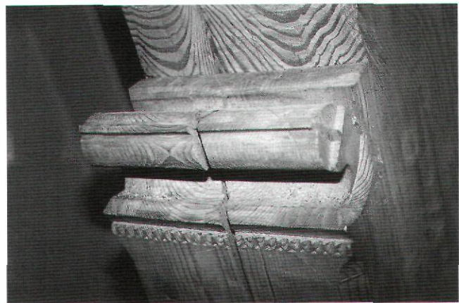
Afb. 12. Academiegebouw Universiteit Leiden, gotisch sleutelstuk van grenenhout, in 1616 aangebracht onder de zoldervloer, boven de Senaatskamer (foto auteur 2004)
