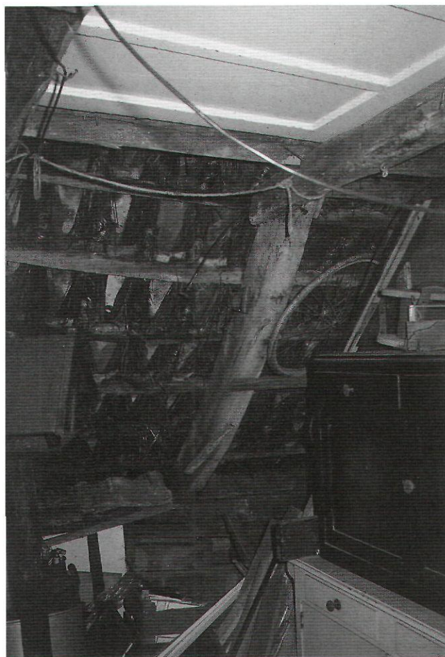
Afb. 1A. Sporenkap met strodokken onder de pannen in Kapelstraat 12 Ootmarsum (foto auteur 1986)
