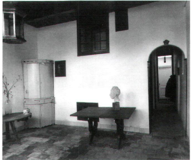
Afb. 12. Oranjegracht 91 (kort na 1658), de voorruimte op de begane grond van het voorhuis. In de scheidingsmuur zijn raampjes voor de kelder (midden-onder), de bedstede (links), een kast (midden-boven) en de spiltrap (rechts) opgenomen (foto RdMz, foto- en tekeningenarchief)
