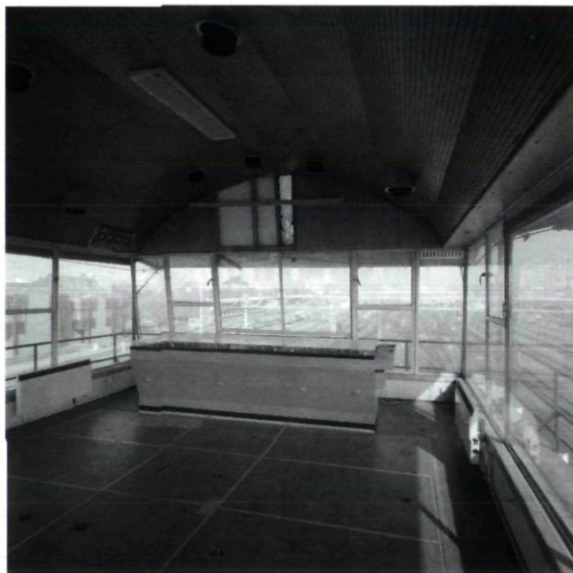
Afb. 9. Maastricht, seinhuis Post T, interieur van de bedieningsruimte met het (bovendeel van het) meerrijige bedieningstoestel, vóór de restauratie. (Rijksdienst voor de Monumentenzorg, Zeist (maart 2003). Fotograaf: G.J. Dukker)
