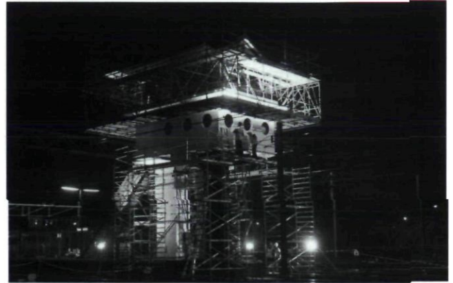
Afb. 13. Maastricht, seinhuis Post T, nocturne tijdens de restauratie. feëriek van karakter en zinderend van bedrijvigheid. (Lardenoije BV Bouwbedrijf, Eijsden zomer 2003)
