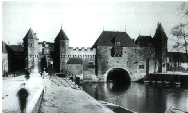
Afb. 6. Amersfoort, Koppelpoort: na restauratie (foto kort na 1890, RDMZ)
