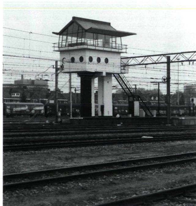
Afb. 11. Maastricht, seinhuis Post T, gezien vanuit het noord-westen, na de restauratie. (Rijksdienst voor de Monumentenzorg, Zeist (november 2004). Fotograaf: K. Roderburg.)
