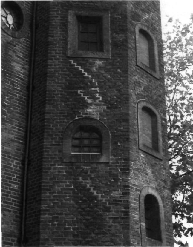
Afb. 5. Meesterproeven in de noordoost toren van de Waag te Amsterdam
