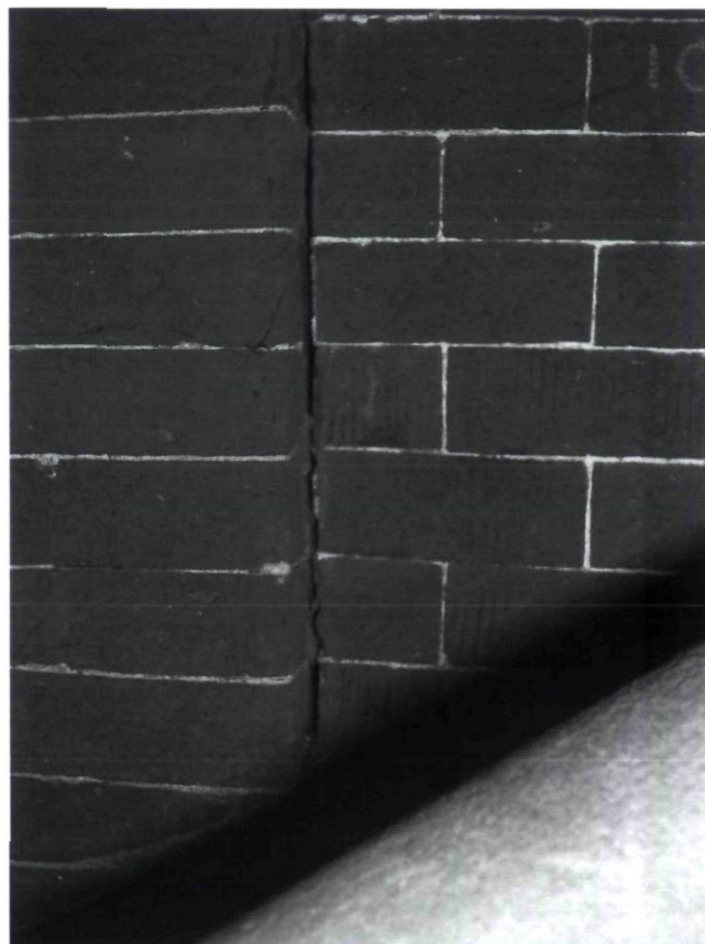
Afb. 11. Verticale groeven op bakstenen in een hoekje boven de trapleuning in de noordoost toren van de Waag
