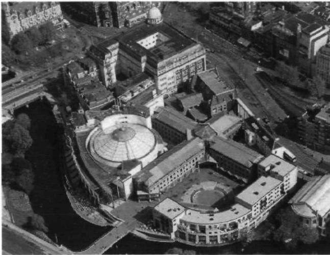
Afb. 2. Hergebruik van de voormalige vleugelgevangenis in Amsterdam als kantorencomplex aan het huidige Max Euweplein. Ontwerp van Zaenen Spanjers cs. Architecten (foto Aviodrome Luchtfotografie, Lelystad 1992)
