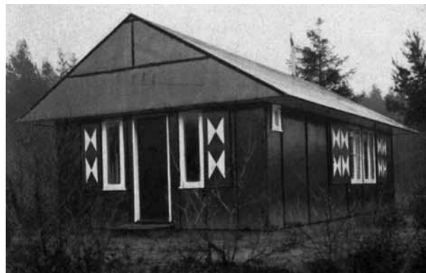
4. Technisch bureau Van de Goes en Van Lanschot, vakantiehuysje, jaren dertig (in: P. Bromberg, De kleine praktische woning , Amsterdam s.a., 21)
