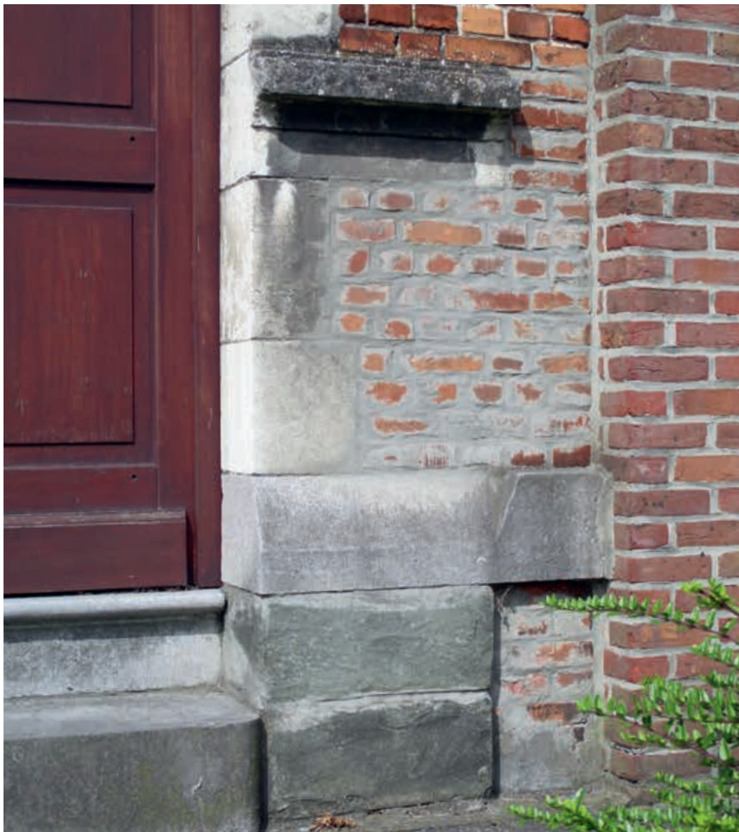
12. De specifieke kapvorm van de natuursteen in de Sint-Gerardus-school bewijst de authenticiteit van de reconstructie van het modelschoolgebouw uit het Moderne Dorp
