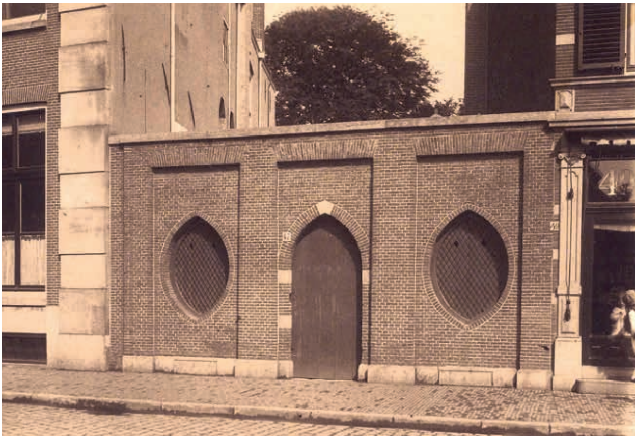
16. De muur voor het gedeeltelijk vrijgekomen erf van Kruisstraat 47, conform de tekening uit 1807. De deur bood toegang tot de daarachter gelegen binnenplaats, dienstvertrekken en tuin van Kruisstraat 45, ca. 1910 (afgebroken) (Berend Zweers, Noord-Hollands Archief/Historische Vereniging Haarlem)
