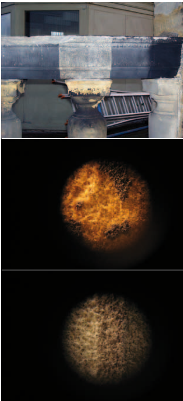
9. Effect van reinigen in de praktijk op macroscopische en microscopische schaal. De foto linksboven toont een regel van de balustrade. Deze is, met uitzondering van het zwarte rechter deel, eerst gereinigd door droog microstralen; vervolgens is het middelste deel ook gereinigd met laser. De foto rechtsboven laat een blok zien na reiniging met op het rechter deel van de foto een niet gereinigde strook die als referentie gehandhaafd is. De middelste foto's zijn in het werk gemaakt met een camera met een microscoop. Ze tonen een microscopisch detail van een baluster, waarop sprake was van het afschilferen van de zandsteen. De foto's tonen de situatie voor (links) en na (rechts) droog microstralen. De losse zwarte schilfers zijn nog steeds aanwezig en niet in omvang afgenomen. De laatste foto is ook een in situ microscopische foto. Hierop is de overgang te zien tussen wel en niet gereinigde steen in het blok op de foto rechtsboven; de microstructuur is identiek (foto's Timo G. Nijland)
