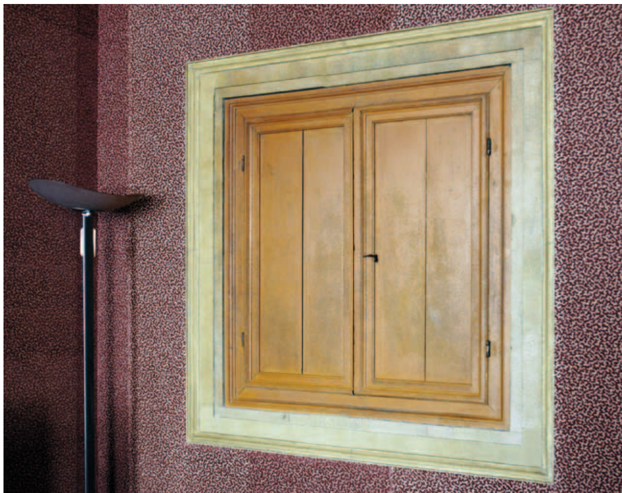
10. Muurkast in de Secretarie na restauratie (foto Stichting Restauratie Atelier Limburg)
