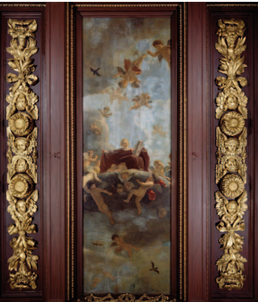
2. Detail van het plafond van de Weeskamer voor restauratie. De vergeelde, glimmende vernislagen belemmerden sterk het trompe-l'oeil -effect van de blauwe luchten en het gevoel van ruimte. De architectonische omkadering is mahonie rood (foto Stichting Koninklijk Paleis Amsterdam, Tom Haartse)
