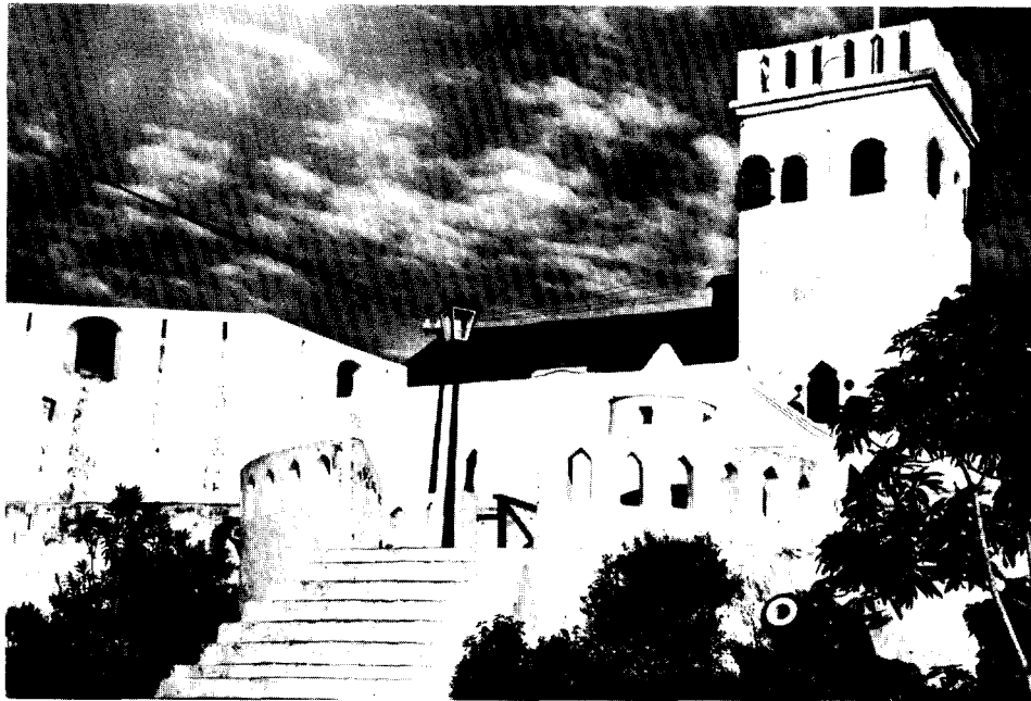
Afb. 18. Elmina, Sint Jago, frontaal aanzicht met uitzichttoren en toegang „ravlijn”. De typerende balustradevorm (vgl. ook afb. 23) berust op het schuin tegen elkaar plaatsen van bakstenen. (Foto's C. I. Temminck Groll)
