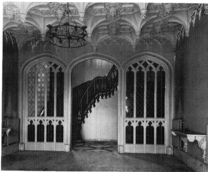
Afb. 14. De glazen deuren in de vestibule met de trap op Schaffelaar, tegenwoordige toestand; ook hier stelle men zich inplaats van het glas in lood spiegelruitenvoor. (Foto Monumentenzorg)
