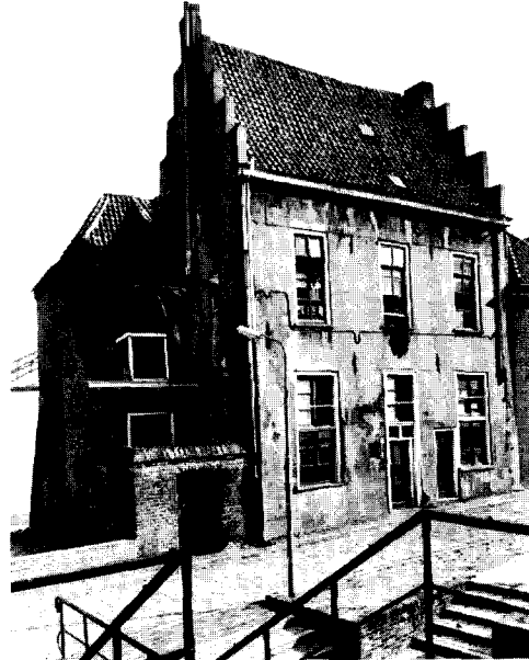
Afb. 9. Zeilmakerij, Steenstraat 57 — Waalkade 65. Laatgotisch huis, voor restauratie bestemd. (Foto Monumentenzorg, 1957)
