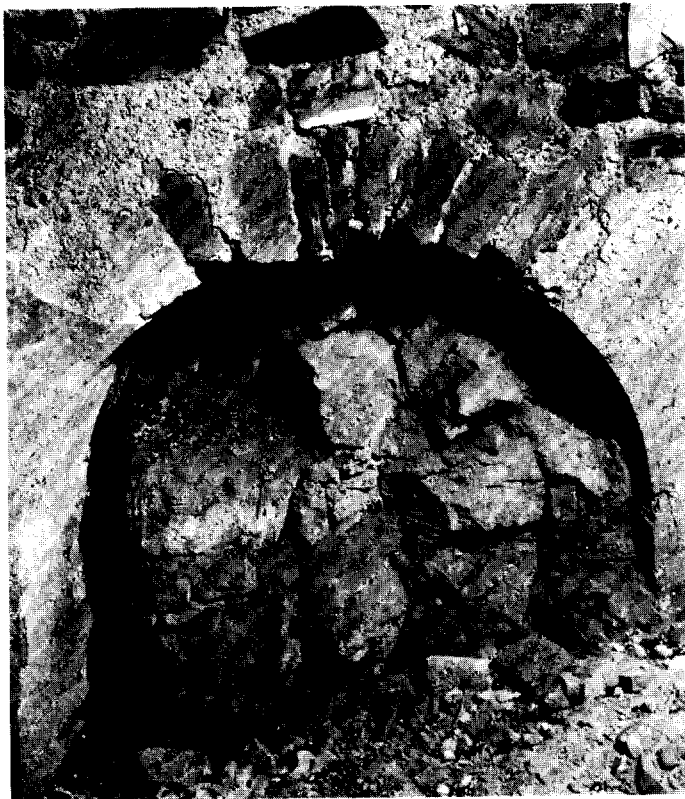
Afb. 5. Maastricht, St.-Servaaskerk. Venster van de zuidbeuk, tegenwoordig schuilgaande onder het dak van het Bergportaal. Houten raam nog juist zichtbaar. Buitenbepkeisteringen uit de bouwijd, eind 10de eeuw. Vgl. fig. 2.
