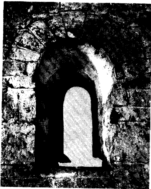
Afb. 3. Rinsumageest (Fr.). Binnenzijde van een venster. Flauw hellende dorpel. Dunne pleisterlaag uit de bouwtijd, eerste helft 12de eeuw. Vgl. fig 7.
