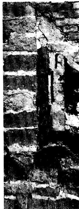
Afb. 6. Utrecht, Pieterskerk. Detail venster in koorlichtbeuk. Strook specie, waarmee houten raam was aangestroken. 11de eeuw. Vgl. fig. 4.
