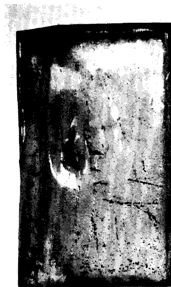
Afb. 6. Utrecht, Pieterskerk. Detail venster in koorlichtbeuk. Strook specie, waarmee houten raam was aangestroken. 11de eeuw. Vgl. fig. 4.
