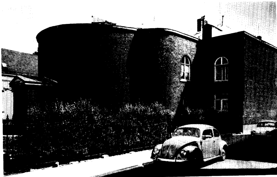
Afb. 10. Synagoge uit 1839-'40, te Maastricht van stadsarchitect M. Hermans. Uit het zuidwesten. (Foto Monumentenzorg, 1962)
