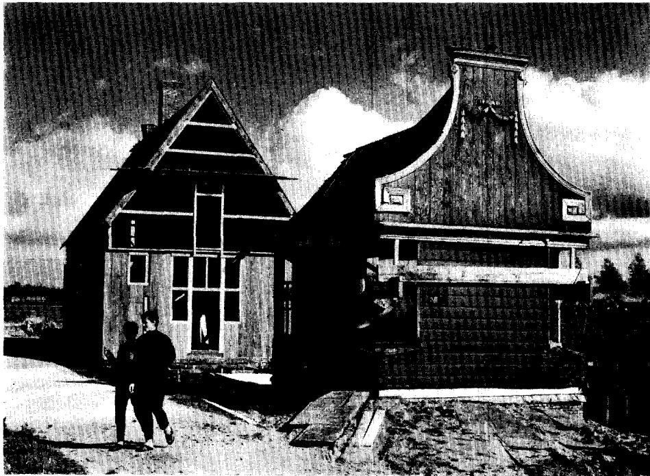
Afb. 8. Links het huis Jagerspad 1-3 uit Zaandam in herbouw. Rechts het per dekschuit overgebrachte deel van het huis Zeilmakerspad 6 uit Westzaan.
