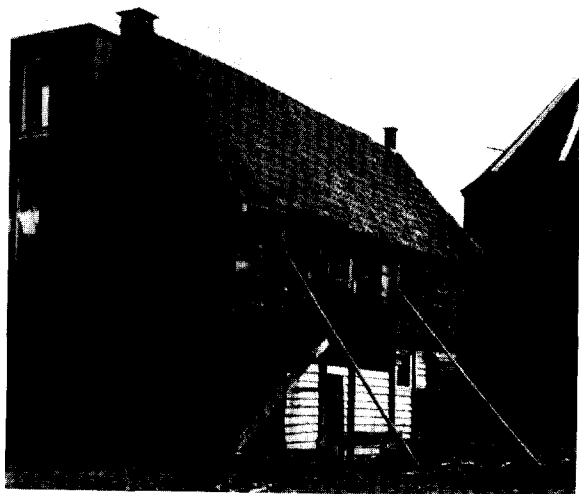
Afb. 1. Het huis Noorderkerkstraat 7 te Zaandam op zijn oude plaats.
