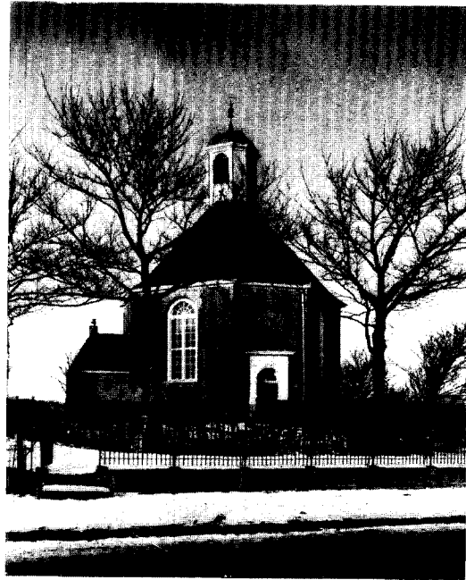
Afb. 2. Gerestaureerd exterieur met vernieuwde hoofdingang, consistoriekamer en dakgoot. (Foto Monumentenzorg, 1964)
