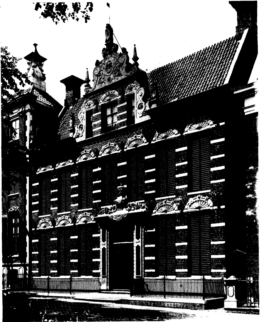
Afb. 10. Ossenmarkt 5, 1624, wellicht toe te schrijven aan Garwer Peters. Ingangspartij 1723.
