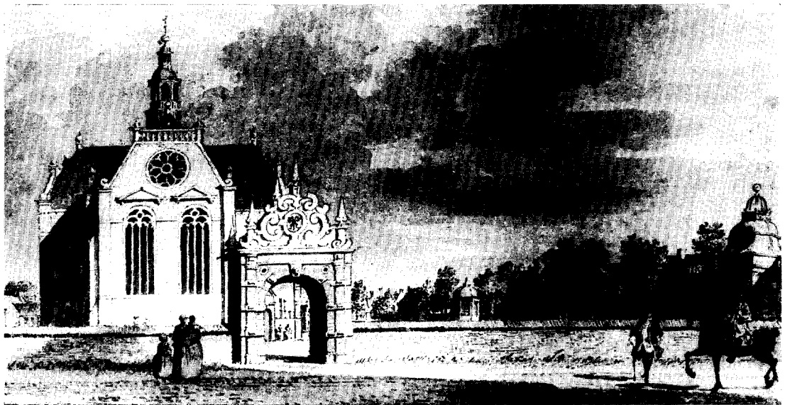
Afb. 5. Toegangspoort tot het Nieuwe Kerkhof, ± 1623, toegeschreven aan Garwer Peters. Tekening C. Pronk, 1754/1756. (Groninger Museum)
