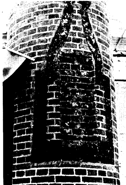
Afb. 12. Groningen, Martinikerk. Bakstenen pijler aan de zijde van de kooromgang. Nisomlijsting direct op de baksteen geschilderd.
