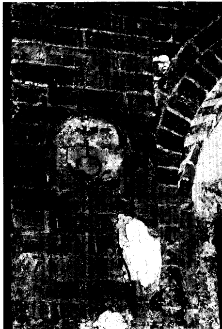
Afb. 2. Huizinge, herv. kerk. Liseen aan de noordzijde. Wijdingskruis en ingangsomlijsting. Op de baksteen geschilderde namaakvoegen, die niet overal kloppen met het steenverband.
