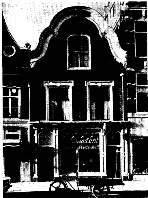
Afb. 6. Zijlstraat 86, Haarlem (3de kw. 18de eeuw). Gelobde topgevel, in Nederland vrij zeldzaam, daarbuiten na de Gotiek nauwelijks voorkomend. (Foto Monumentenzorg)
