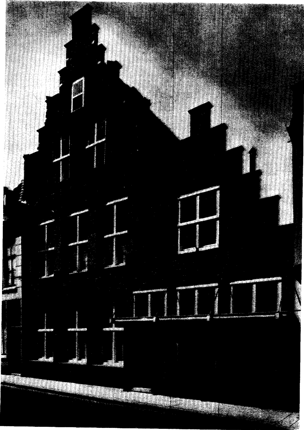
Afb. 18. Voorstraat 27. Goed bewaard gotisch pand van omstreeks 1500 met oorspronkelijke zijkamer, die van een 17de-eeuwse gevel werd voorzien, welke laatste in 1931 geheel is vernieuwd. (Foto Monumentenzorg)
