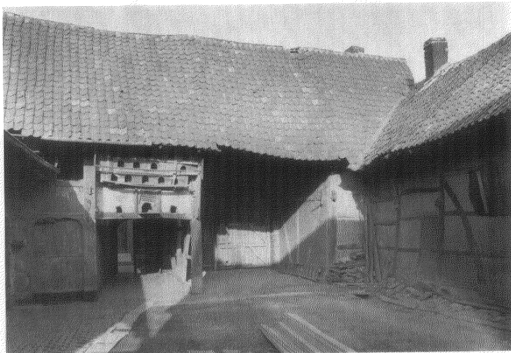
Afb. 4. Putstraat 6 te Lutterade. De poortvleugel uit 1765 aan de kant van de binnenplaats. Links de deur van de koestal; in het midden boven het voetgangerspoortje het duivenhok; geheel rechts de hoekschoor van de in 1745 voltooide stal. (Foto Monumentenzorg)
