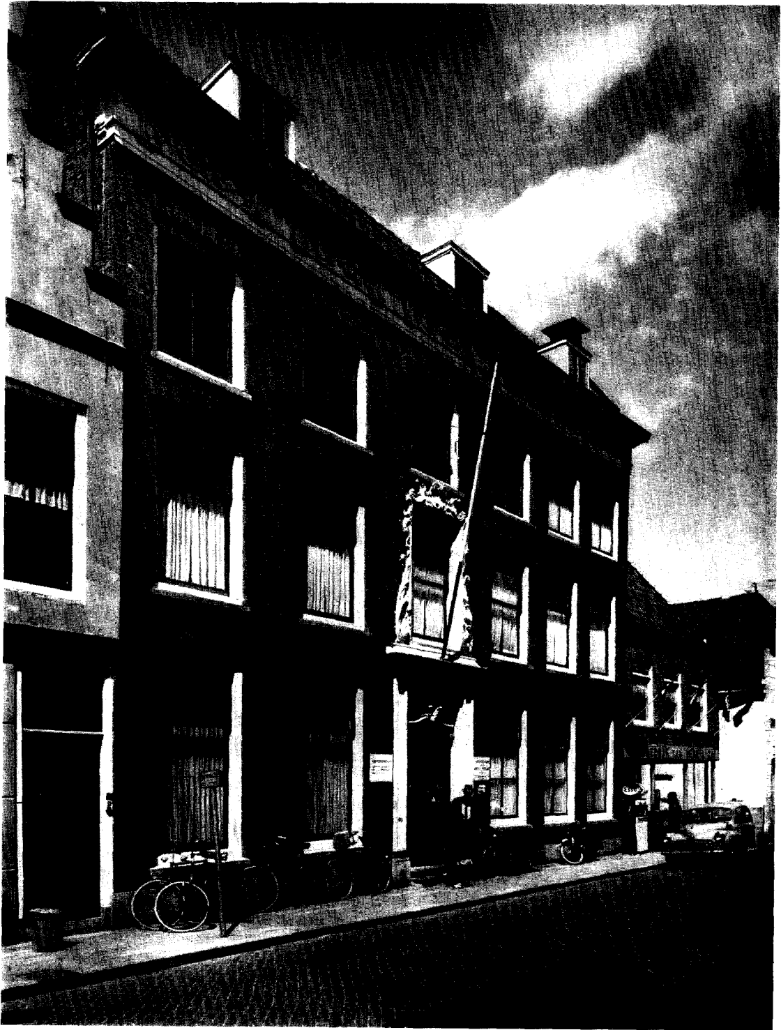
Abb. 17. Voorstraat 29 en 31. Het huis nr. 29 bevat nog enkele laatgotische fragmenten. Nr. 31 heeft een der mooiste 18de eeuwse gevels van de stad; hiervan zijn de beide rechtse traveeën het jongst. Het linkerdeel van het gebouw bevat nog een 16de eeuwse huis met zijkamer. (Foto Monumentenzorg)
