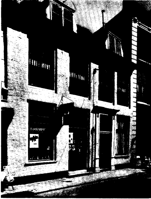
Afb. 8. Nobelstraat 3-5. Huis met zijkamer. Ondanks 18de eeuwse verbouwing bleven in de gevel nog enkele middeleeuwse fragmenten (hoek-blokken) herkenbaar.
