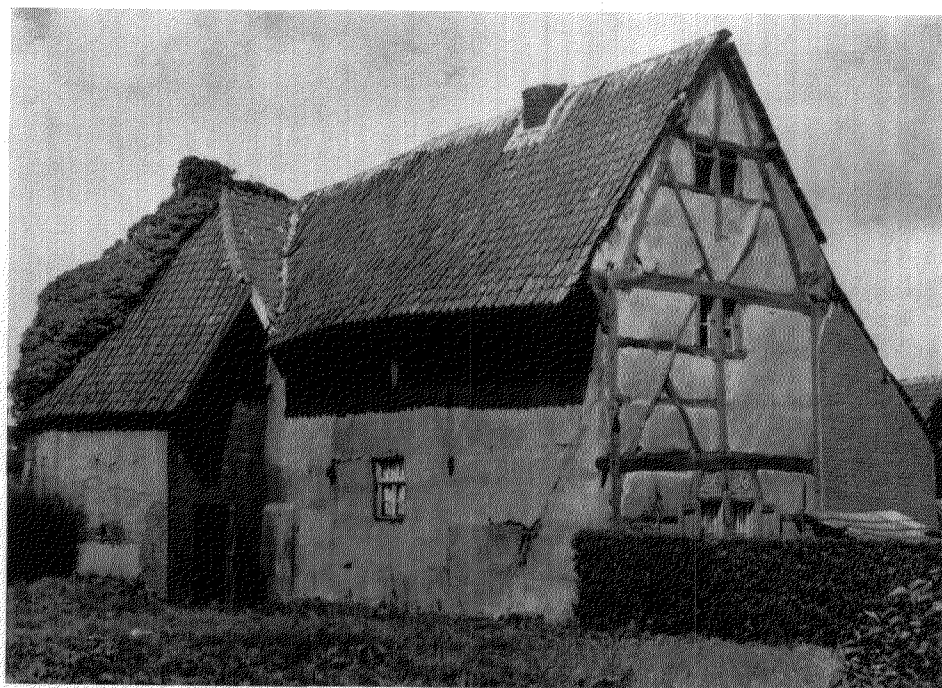
Afb. 2. De boerderij Putstraat 6 te Lutterade voor de sloop van het woonhuis op 31-10-1964. (Foto Monumentenzorg)
