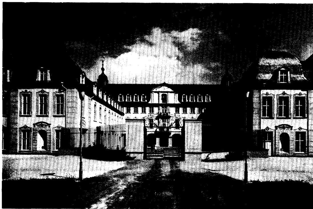
Abb. 2. Teilansicht der Südseite.
