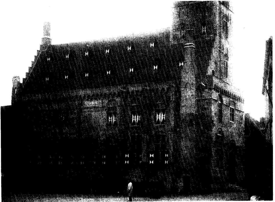
Afb. 4. Noordzijde na de restauratie van 1894-1904.
