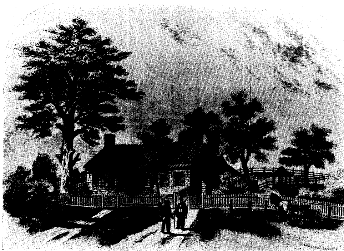
Afb. 3 Vicasius de Sillé, New Utrecht, Long Island, 1657; afgebroken in 1850.
