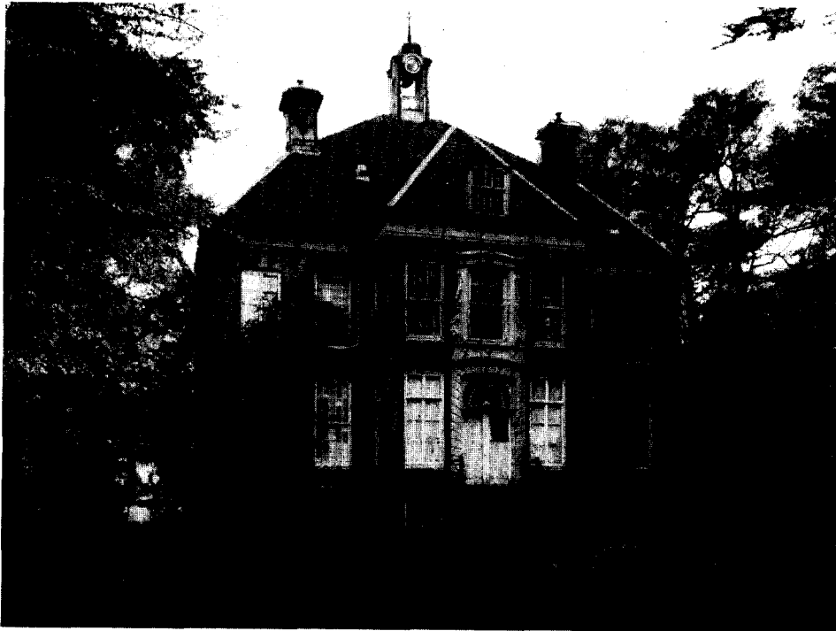
Afb. 3. Achterzijde van Sparrendaal voor de restauratie. (Foto Monumentenzorg, 1955)
