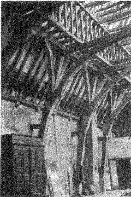
Afb. 3. Detail van de kapconstructie van het Sint Janshospitaal te Brugge. (Foto dr. L. Devlieghe)
