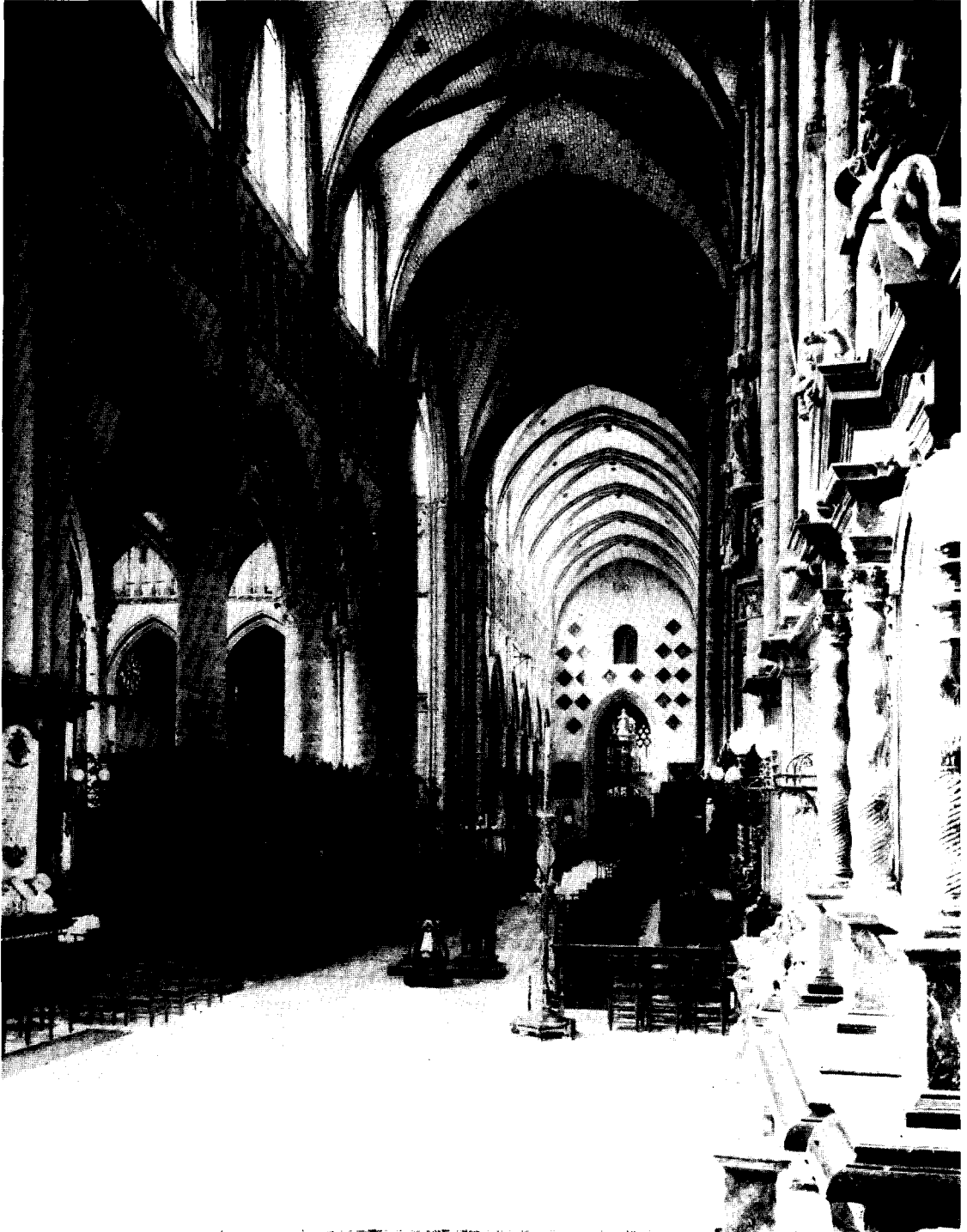
Afb. 2. Leper, Sint Maarten. Koor begonnen in 1221; dwarspand en schip: tweede helft 13de eeuw-14de eeuw. In het koor heeft het Doorniks triforium rondboogjes op afwisselend pijlertjes en zuiltjes. Verwoest in 1914-'18; herbouwd na 1918. (Foto Antony, 11 mei 1914)
