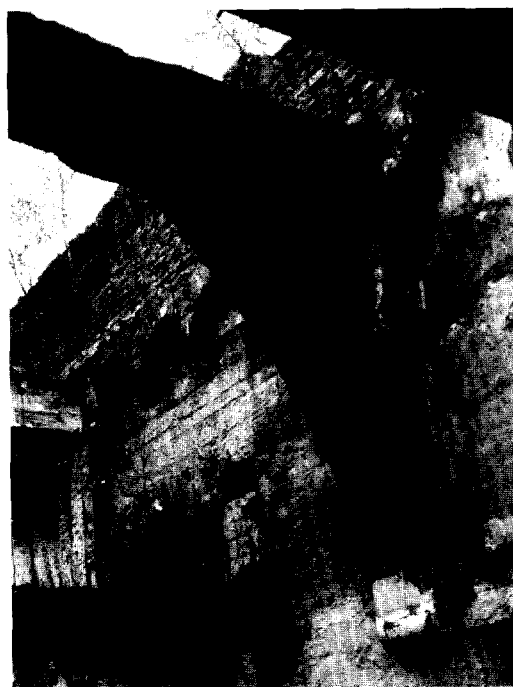
Afb. 26. Detail van de zuidelijke zaalwand. Trekbalk met korbeel, segmentboognis en boogfries uit de eerste helft van de 15de eeuw. (Foto Monumentenzorg, 1953)
