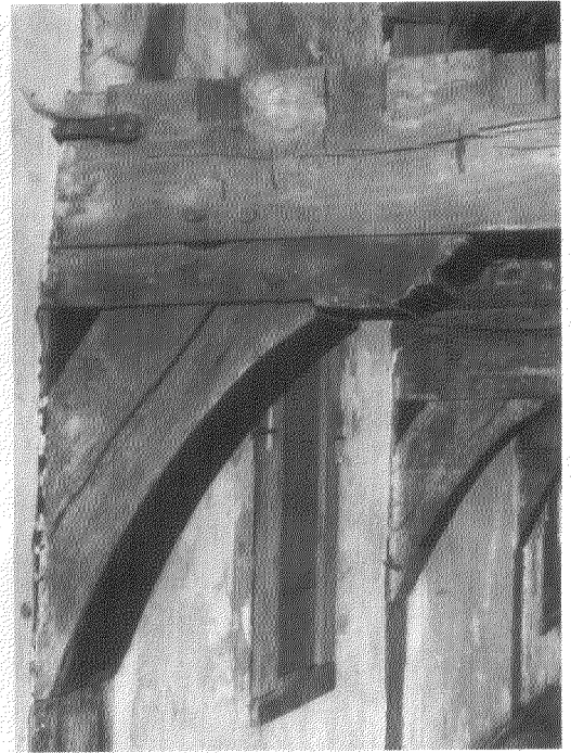
Afb. 5. Bolsward, Grote Dijklakker 22, balklaag omstr. 1600. Inkepingen (voorloeven) zichtbaar door verwijdering van de kinderbinten.
