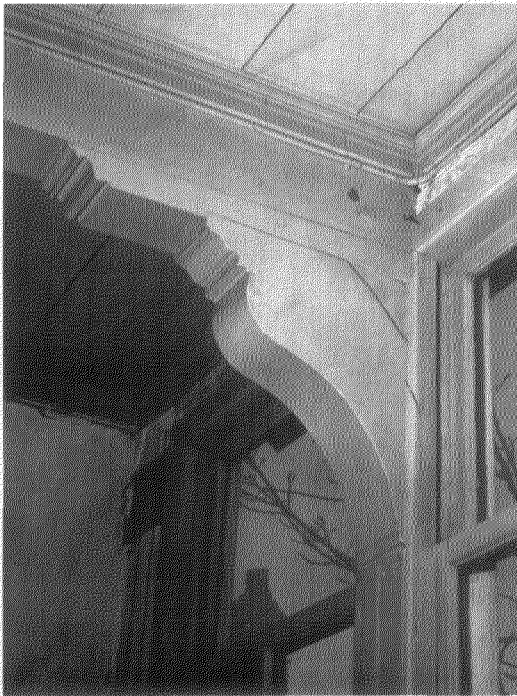
Afb. 6. Zaandam, Jagerspad 5 (overgebracht naar Zaanse Schans). Sleutelstuk van eikehout, balk en korbeel van greynhout; omstr. 1625.
