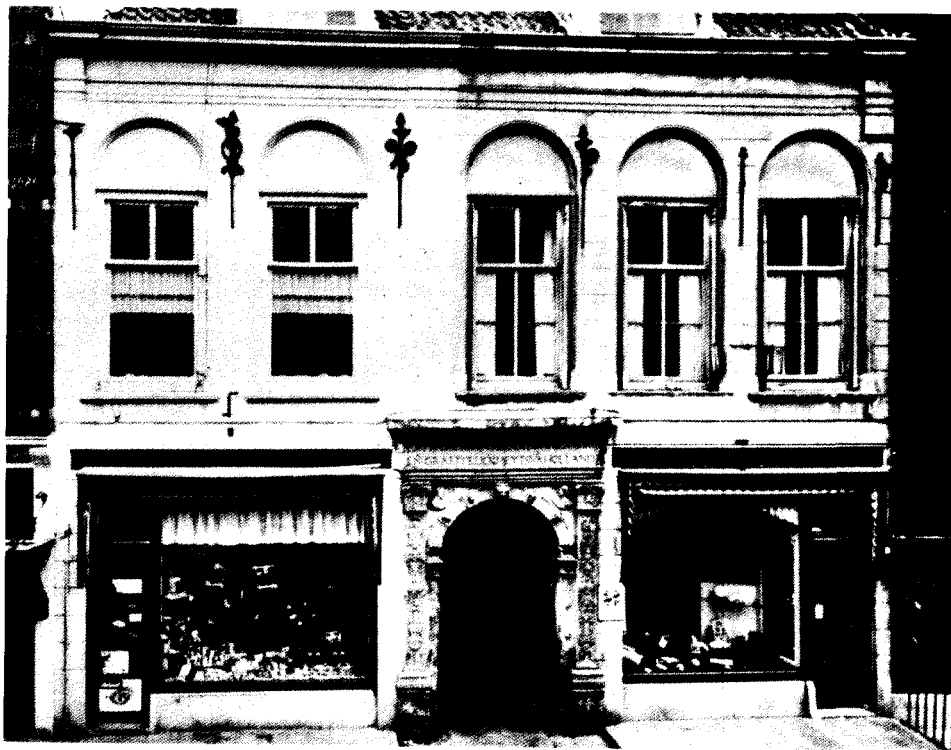
Afb. 6. Het Muntgebouw te Dordrecht voor de restauratie.
