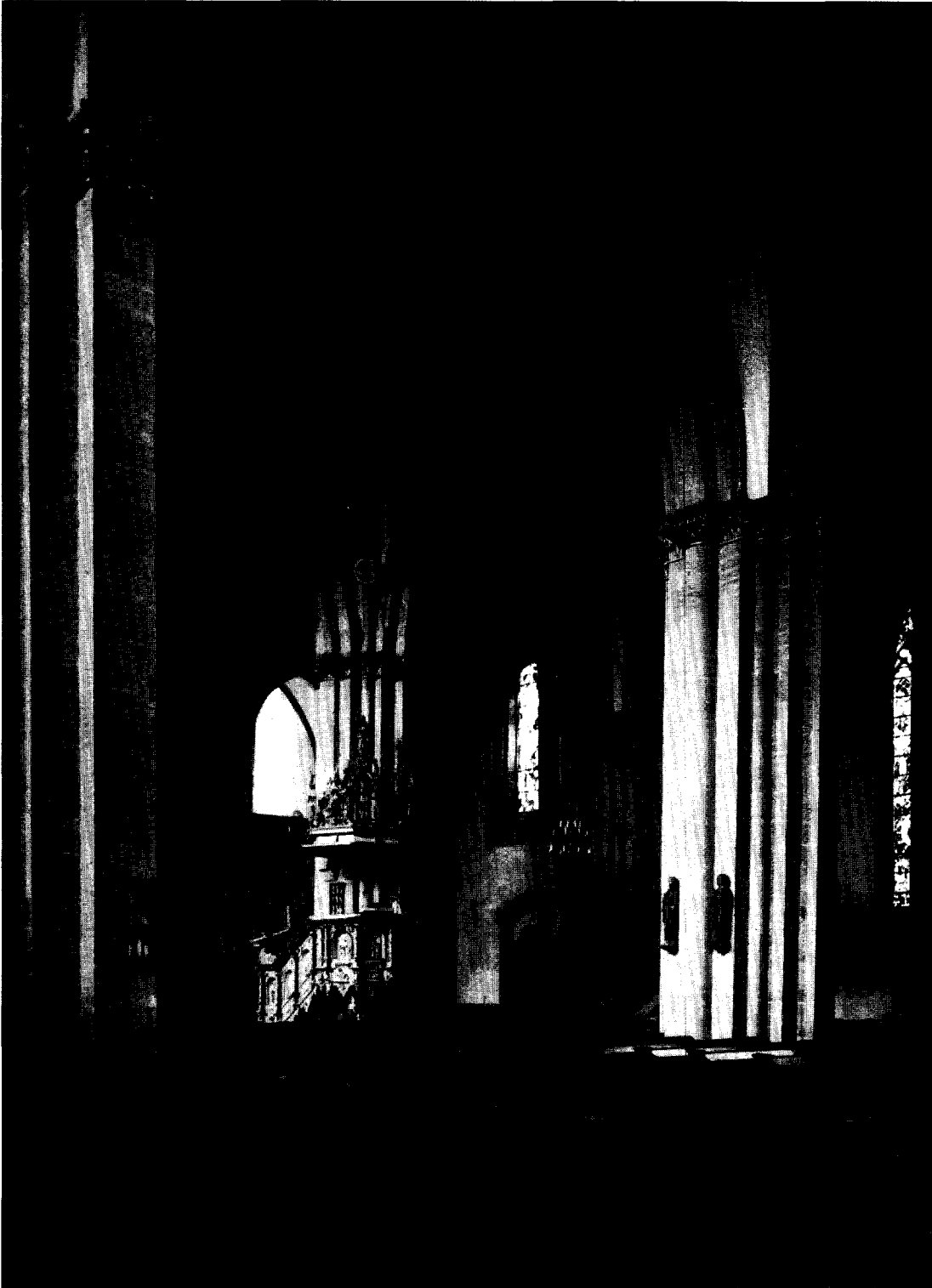
Abb. 4. Herford, Münsterkirche, Blick nach Südosten. In der Hallenkirche mit gleich hohem Ansatz aller Wölbungen erreichen die schweren, gebündelten Pfeiler etwa die Hälfte der Raumhöhe, während die übrige Hälfte des Raumes von den hoch ansteigenden Gewölben gebildet wird.
