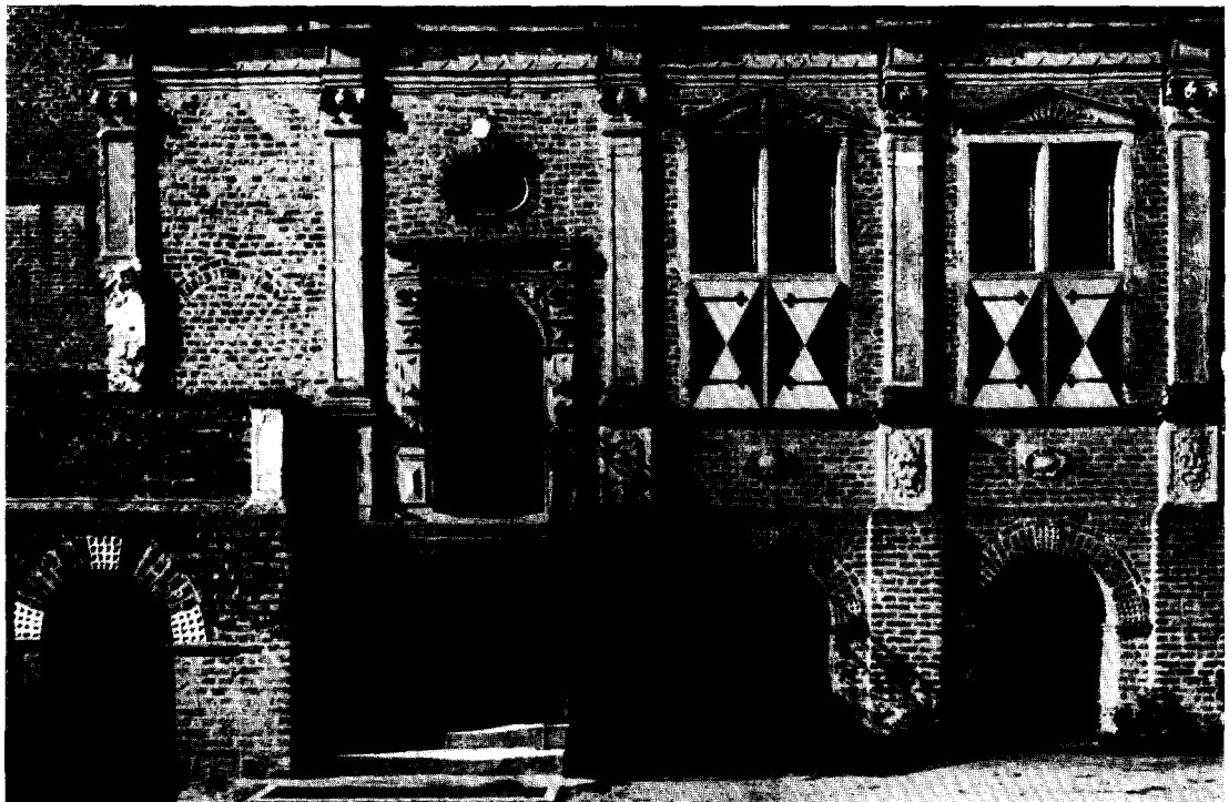
Abb. 21. Raesfeld (Kr. Borken), Schloß, Wandgliederung an der Hofseite des Westflügels. Die Terasse links im 19. Jahrhundert nach Abbruch des Südflügels hinzugefügt.
