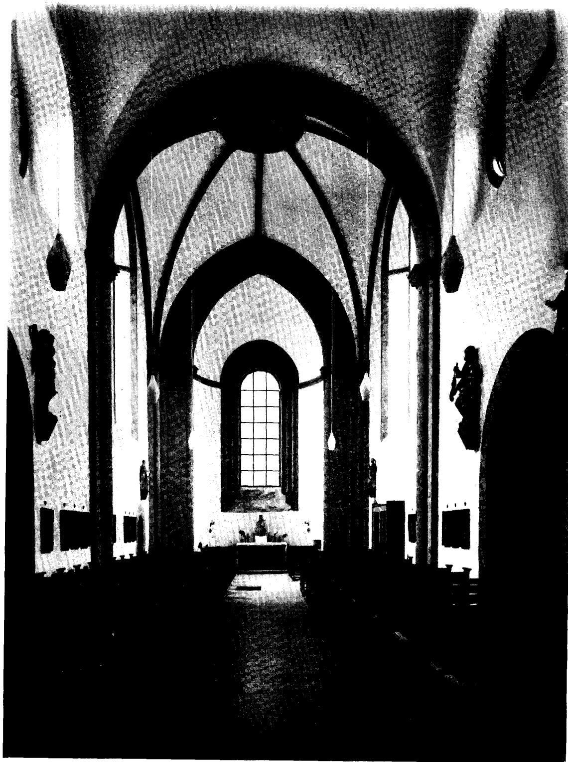
Abb. 5. Erwitte (Kr. Lippstadt), Blick nach Westen in das Turmjoch. Auffallende Verwandtschaft des Turmjoches mit achtrippigem Gewölbe zum Turminneren der St. Plechelmuskirche in Oldenzaal.
