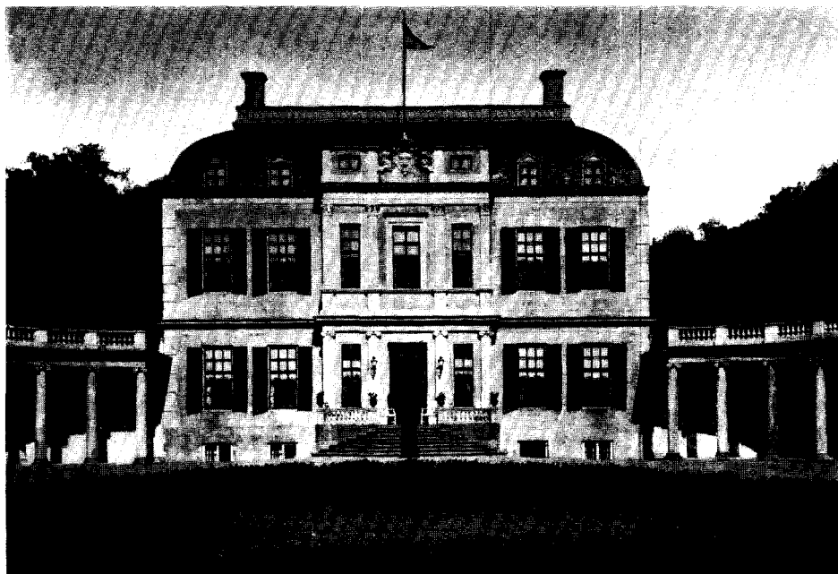
Afb. 4. De Voorst na de restauratie in de jaren 1909-1910.
