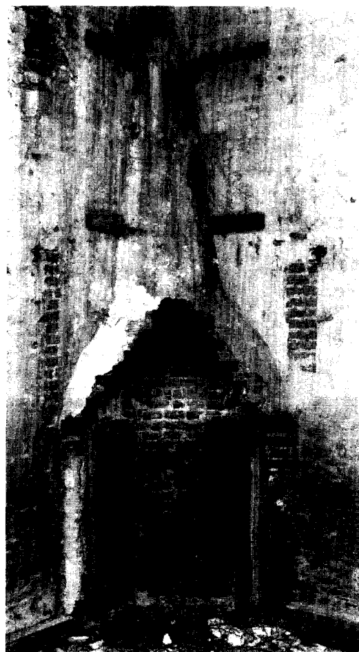
Afb. 10. Overblijfsel van een hoekschouw met voortekening op de muur.
