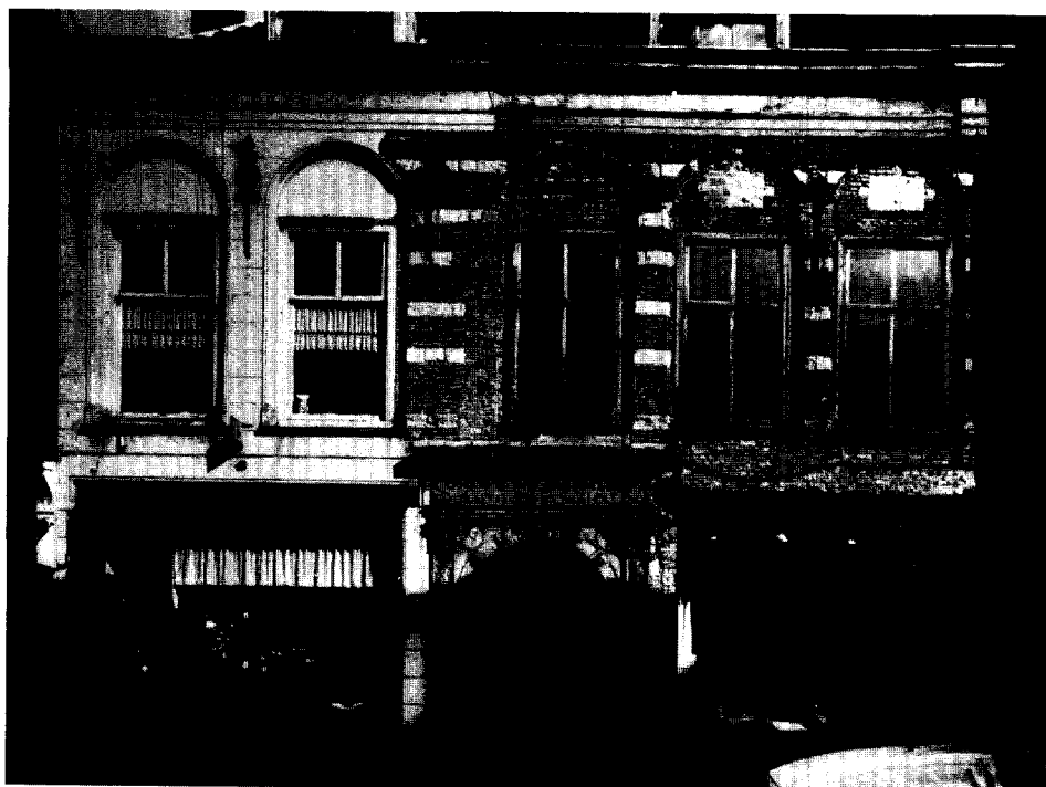
Afb. 7. Het Muntgebouw te Dordrecht. De voorgevel ten behoeve van het restauratieonderzoek gedeeltelijk ontleisterd. (Foto Monumentenzorg, 1963)
