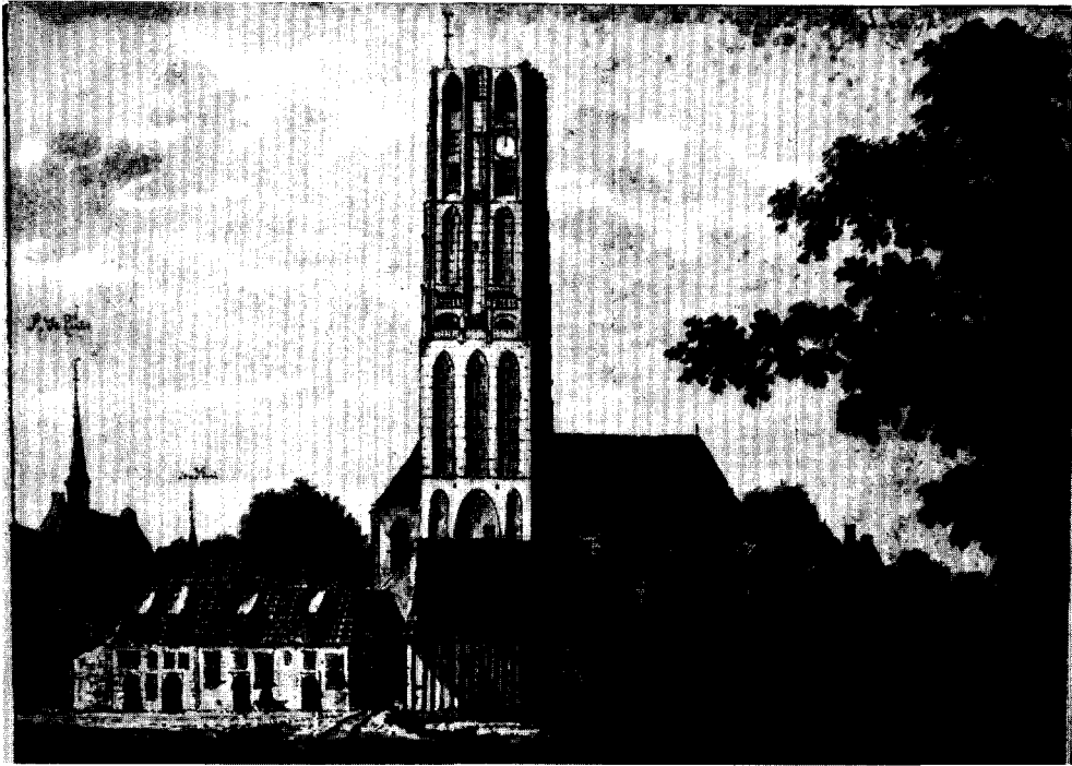
Afb. 5. De kerk in de 18de eeuw voor de instorting van de toren; beide onderste torengelidingen van \pm 1420—1435, bovenbouw laat-15de eeuws. (Archief de Poll)
