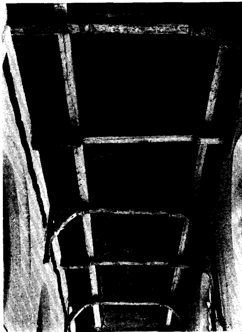
Afb. 14. Kap van de zuidbeuk uit het begin van de 16de eeuw. (Foto's Monumentenzorg)
