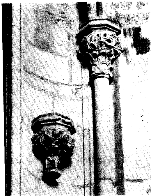
Afb. 20. Kraagsteen en kapiteel in het zuiderportaal.
