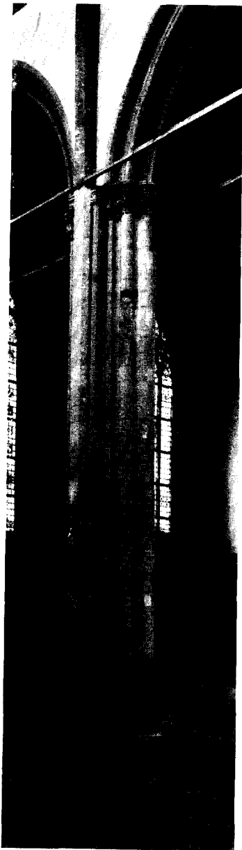
Afb. 5. Pijler tussen het dwarspand en de zuiderzijbeuk.
