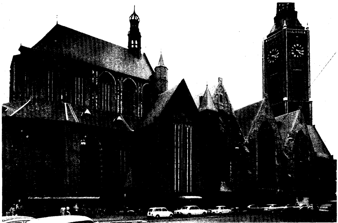
Afb. 11. De kerk uit het noorden na restauratie van de topgevels.
