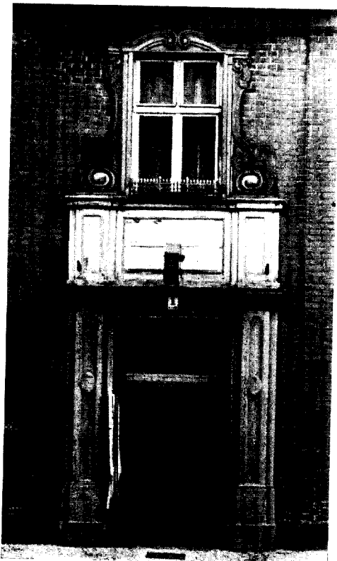
Abb. 6. Straße der Jugend 1. (Aufn. Inst. f. Denkmalpflege)
