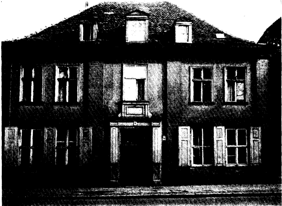
Abb. 8. Straße der Jugend 9. Alleinstehendes Traufenhaus. Die Portaldekoration ist im Obergeschoß zerstört, die Hauptgesimskonsolen sind entfernt.
