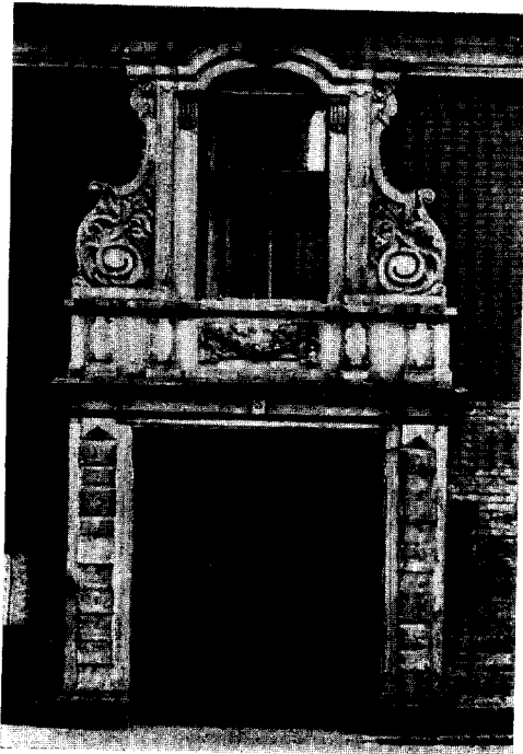
Abb. 4. Straße der Jugend 5. (Aufn. Inst. f. Denkmalpflege.)
