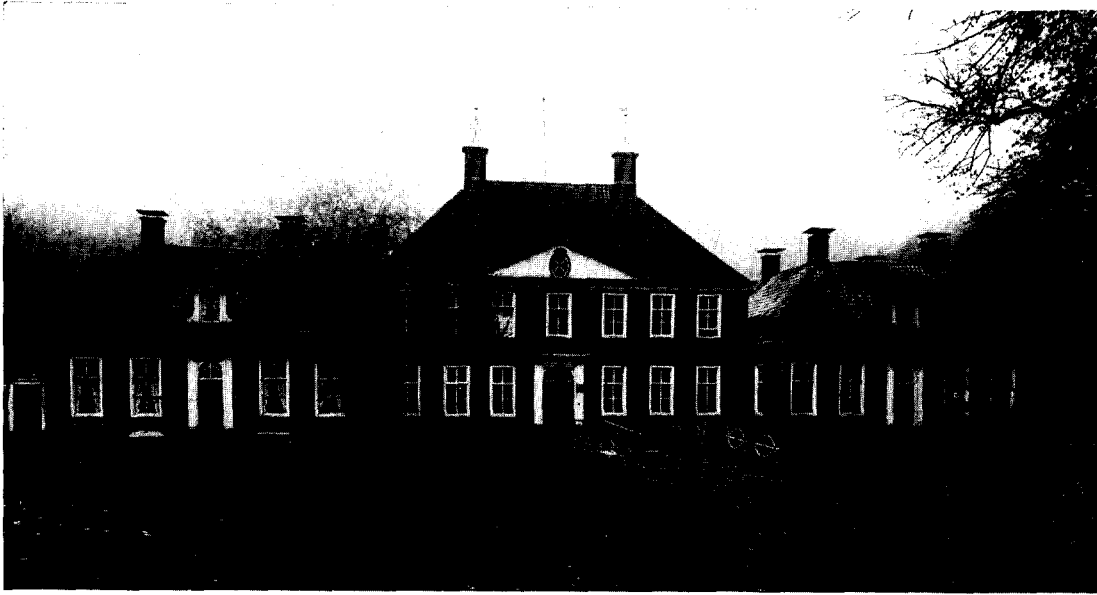
Afb. 1. Laarwoud voor de restauratie
