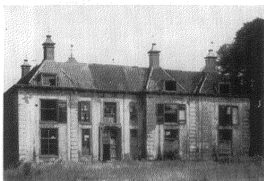
Afb. 6. Achterzijde na de oorlog. (Foto Monumentenzorg)
