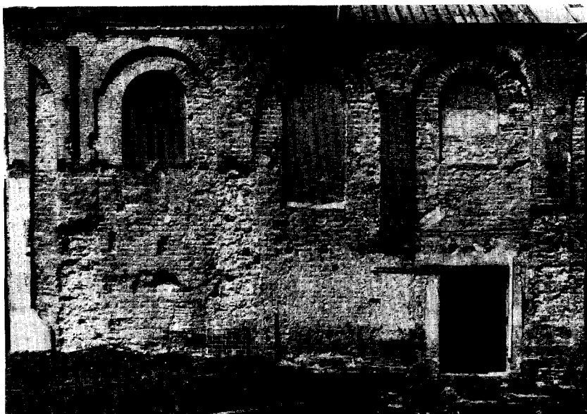
Afb. 9. St. Pieterskerk, gedeelte van de zuidgevel; boven de ingang is de dakmoet zichtbaar van de kruisgang.
