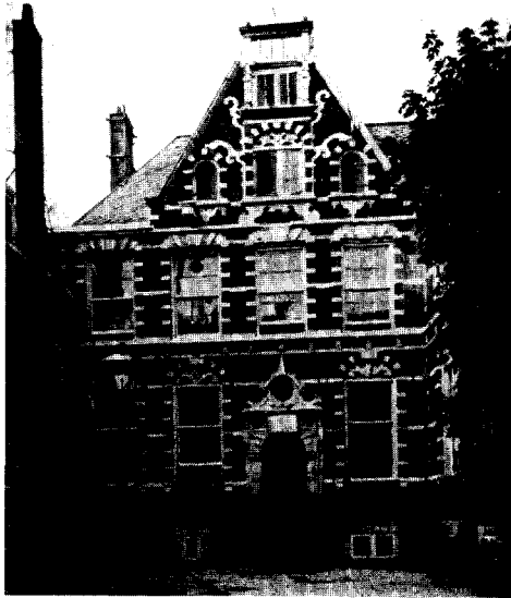
Afb. 4. Binnenplaatsgevel van de vleugel uit 1606, voor de restauratie van 1891
