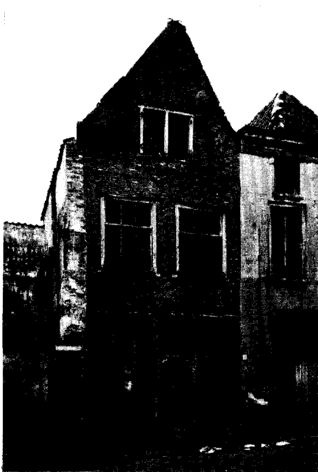
Afb. 14. Nonnenstraat 80, met oorspronkelijke houten pui.
