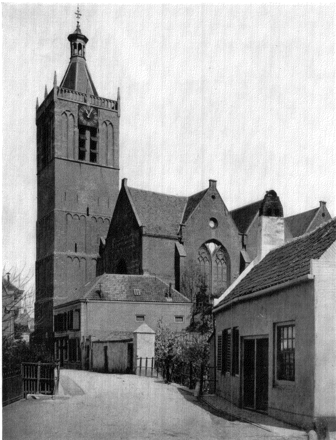
Afb. 1. Uit het zuidwesten na de restauratie van 1904.
