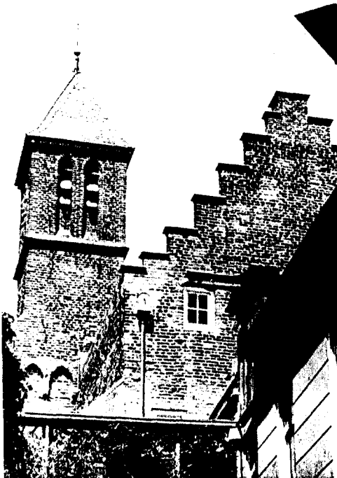
Afb. 5. Achtergevel en toren, na de restauratie. (Foto ir. C. L. Temminck Groll)
