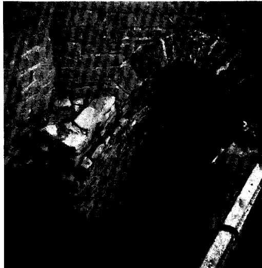
Abb. 4. Uiteinden van oudste fundering onder zuidelijke traptoren. De spaarboog behoort bij grondslag traptoren. (Foto Postma)
