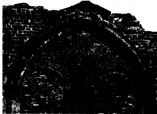
Afb. 6. Bovenkant van het westelijke venster voor de restauratie. (Foto Monumentenzorg)
