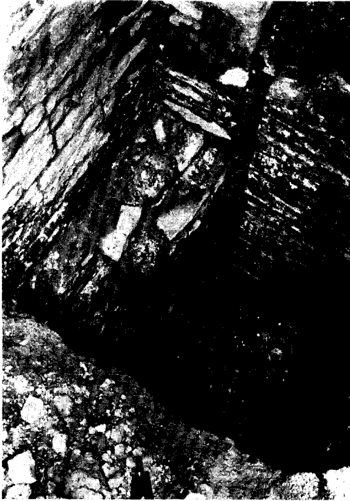
Abb. 1. Aansluiting van oudste fundering met beëindiging zijkoor aan zuidzijde; hoeklisene van vroeg-gotisch gebouw. Geheel rechts steunbeer behorend tot achterkerk. (Foto Renaud)
