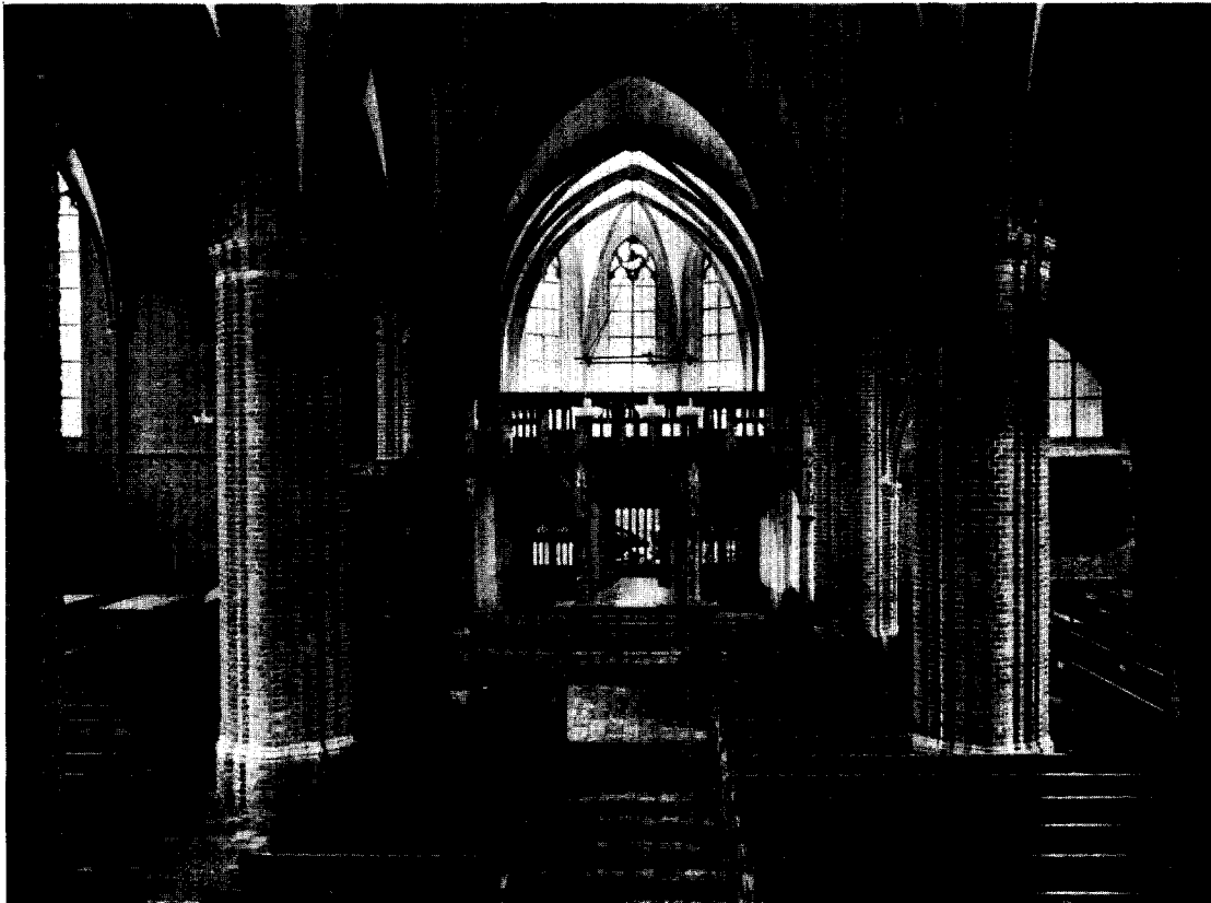
Afb. 3. Renen, St. Cunerakerk na de sinds 1934 ondernomen restauraties. Het z.g. „schoonwerk” bederft de ruimtewerking en verdoezelt het architectonische spel van lijnen en vlakken.
