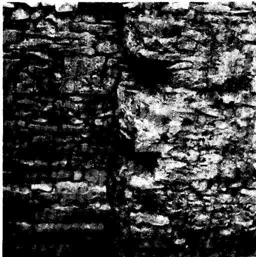
Abb. 3. Binding van oudste fundering, naast traptoren aan zuidzijde, met fundering zuidelijke zijbeuksmuur. (Foto Postma)
