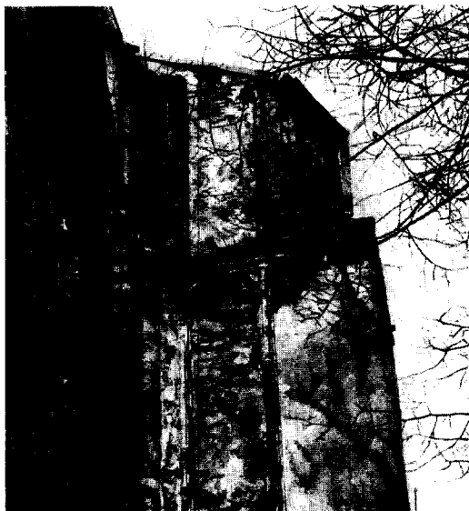
Afb. 6. Restanten van het grote venster in de Noordertranseptgevel van het „Nieuwe Werk” en de daarbij behorende binnendecoratie. Links de dichtgemetselde opening naar de nog bestaande zijbeuk van dit transept.
