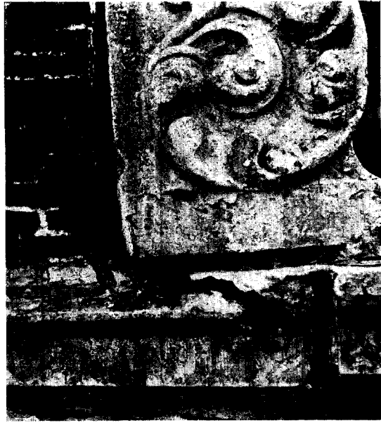
Afb. 2. Amsterdam, N.Z. Kolk 11. Zettingen in de geveltop en breuken in de natuursteen door roestwerking van de ankers.
