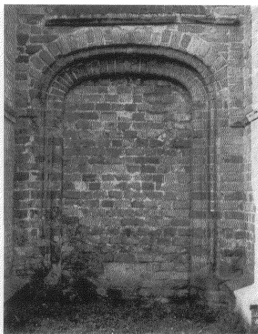
Afb. 8. Gesloten zijingang voor de restauratie.
