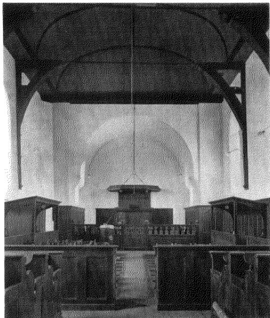
Afb. 5. Interieur naar het oosten voor de restauratie.
