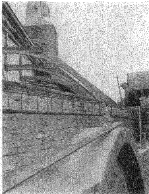
Afb. 10. Nieuwe kasspanen en betonversterking muren kooromgang.
