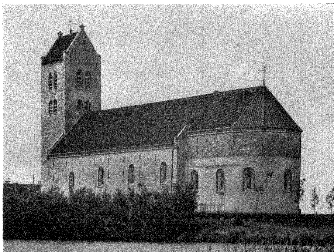
Afb. 2. Zuidzijde na de restauratie.
