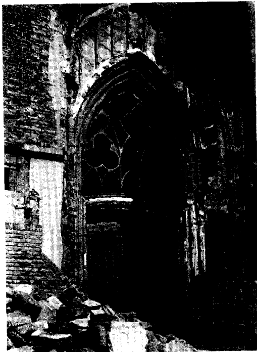
Afb. 6. Zuidportaal van het schip voor de restauratie.
