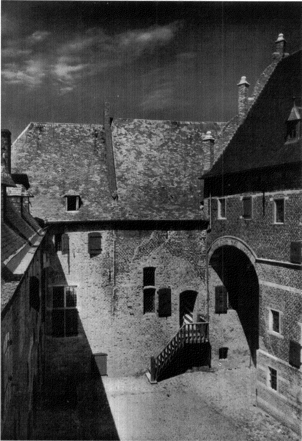
Afb. 5. Kasteel Hernen. Binnenplaats, gezien naar het Noorden, na de restauratie. (Foto George Flipse.)
