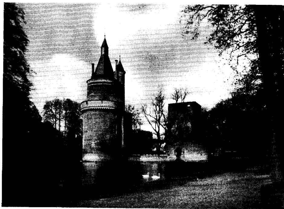
Afb. 12. Wijk-bij-Duurstede. Ronde toren van het Slot ná de restauratie. (Als belangrijk voordeel van het restaureren van de weergang, gold dat door de afdekking daarvan het metselwerk tegen (infiltratie van water wordt beschermd.) (Foto Rijksd. v. h. Oudh. Bodemonderzoek. Amersfoort.)
