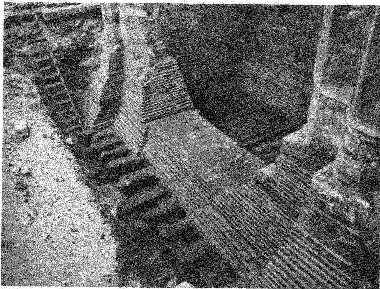
Rotterdam, St. Laurenskerk. Fundamenten van een der kapellen langs de Zuiderzijbeuk. De breed aangelegde muren rusten op vloten van zware, kruiselings gelegde balken, waaruit op gezette afstanden de bases voor de pijlers verrijzen. (Zie Nieuws-Bulletin 1952, kol. 29 e.v.) (Foto: Gerrit Burg, Rotterdam)
