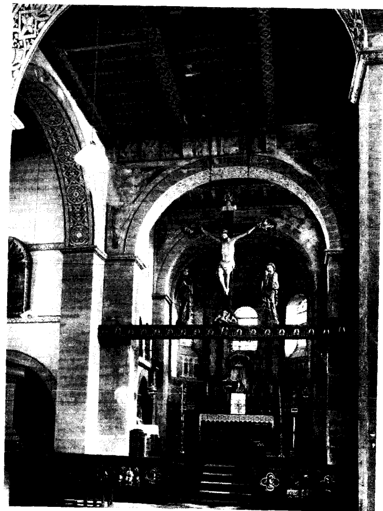
Afb. 2. Susteren. St. Salvatorkerk. Koorpartij. (Foto Lichtbeeldeninstituut, Amsterdam)
