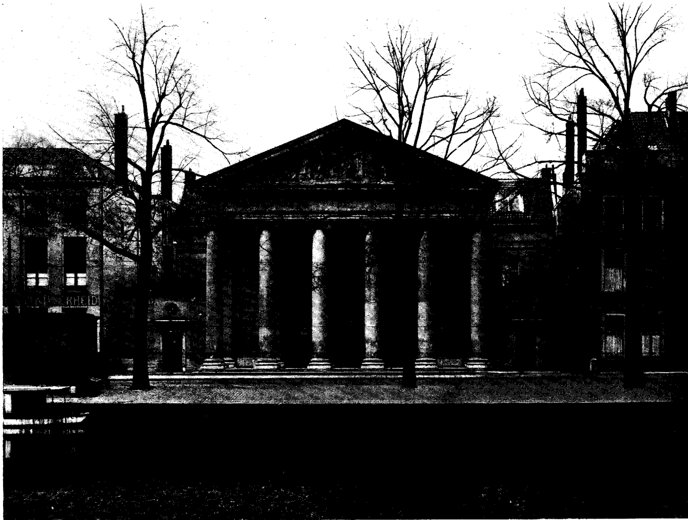
Voorm. Academie van Beeldende Kunsten in Den Haag, gebouwd door Z. Reijers in 1839, gesloopt in 1933.
