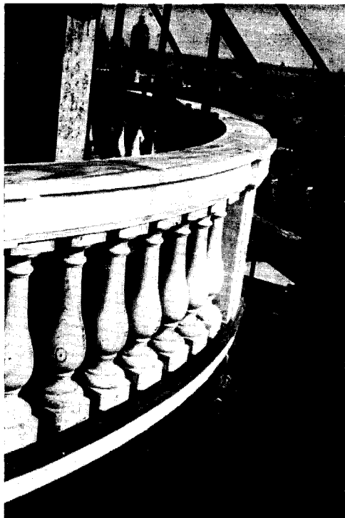
Afb. 5. De balustrade zonder de koperafdekking op de bovenregel.
