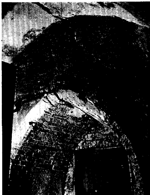
Afb. 6. Scheuren onder het stergewelf op 50 m + .
