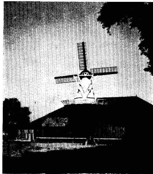
Afb. 6. De stellingmolen te Bovenrijje, onder Garmerwolde (Gr.), ingericht als watermolen, korenmolen, plankenzager en voor aandrijving van een draaibank.
