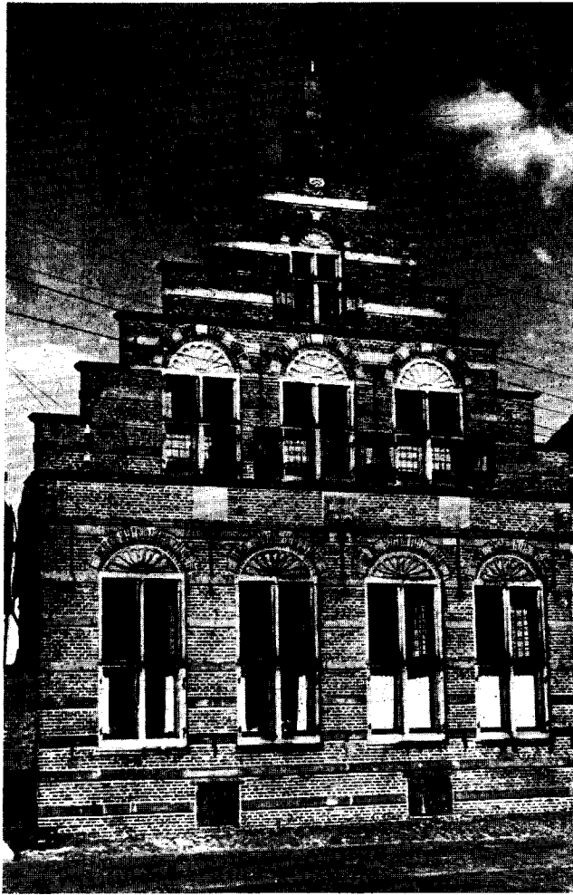
Afb. 2. De in 1919 verbouwde voormalige Latijnse school aan het Kerkplein te Vollenhove.
