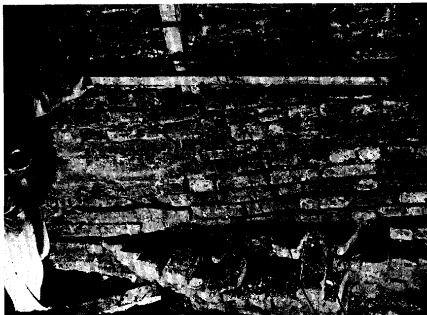
Afb. 1. De onderlagen worden uit de fundamenteen door overbelasting en grondbeweging weggeperst.
