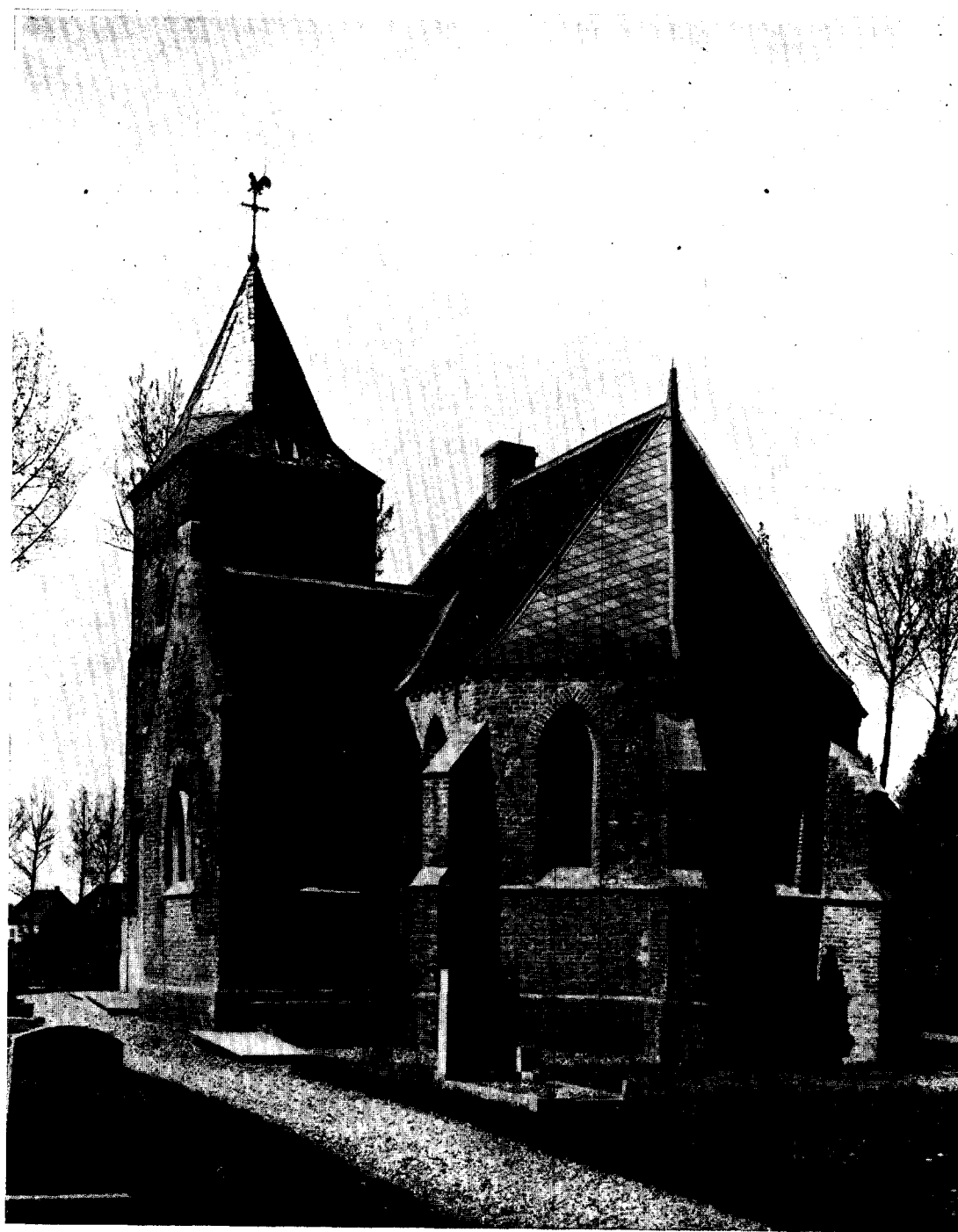
Abb. 4. De Ned. Hervormde kerk te Ressen na de restauratie
