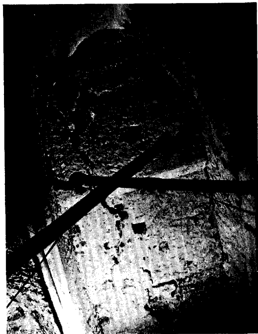
Afb. 5. Scheuren onder het stergewelf op 50 m + .
