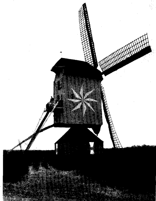
Afb. 8. Gesloten standermolen te Wanrooy (N.Br.). De enige standermolen in Nederland met drie zolders. In bedrijf.
