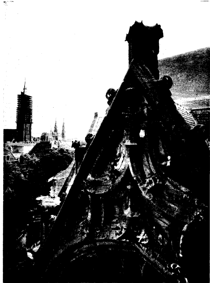
Afb. 23. Oude Kerk te Delft, kapeltopgevel Noord-oostzijde. Bentheimerzandsteen.
