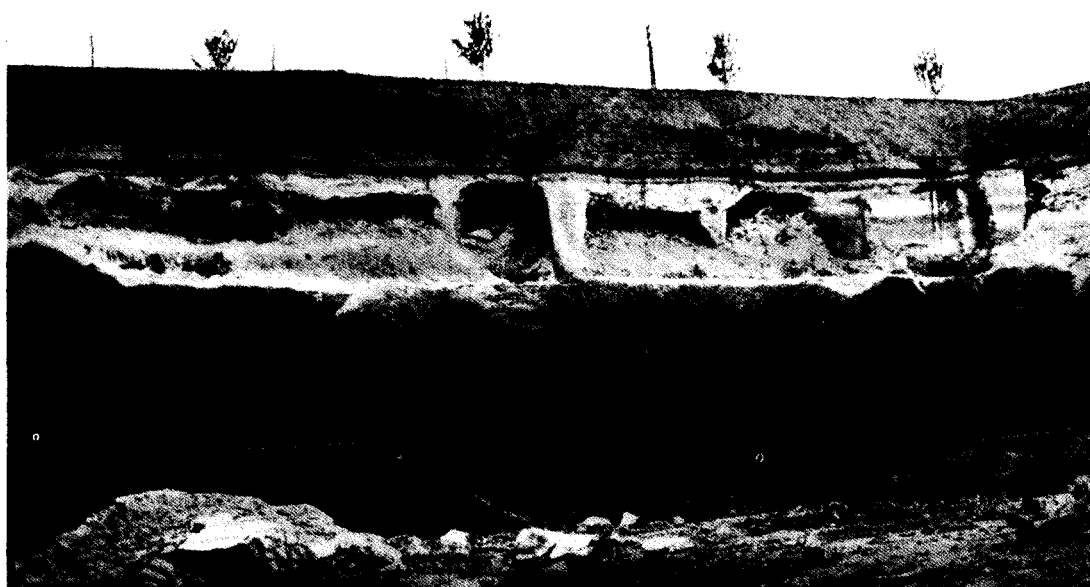
Afb. 6. „Römer stollen”, oude ontginningsgangen in een trastufsteengroeve bij Plaidt.
