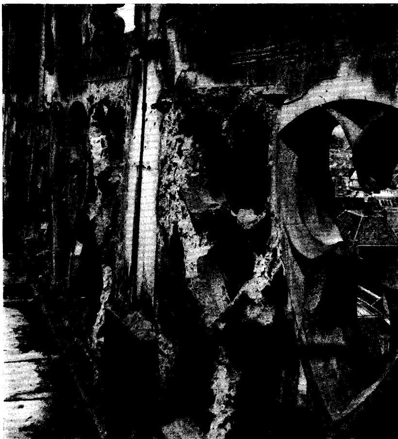
Afb. 13. Balustrade van het schip van de St. Janskerk te 's-Hertogenbosch, Noordzijde, gezien vanuit de goot. Foto opgenomen in 1949. De balustrade is in de jaren 1870-1880 uitgevoerd in Udelfanger zandsteen. Gedeelten zijn gaaf gebleven, andere delen totaal verweerd. De verankering door middel van ijzeren doken is funest voor de constructie. Door roestvorming springen hele stukken los. De ijzeren doken zijn met lood afgedekt, doch dit blijkt totaal onvoldoende.
