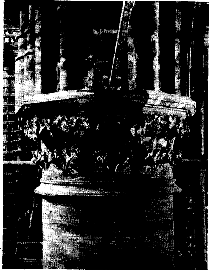
Afb. 21. Grote kerk te Dordrecht. Kapiteel met gedeelte van de schacht en scheiboog van een der schipkolommen. Ledesteen.
