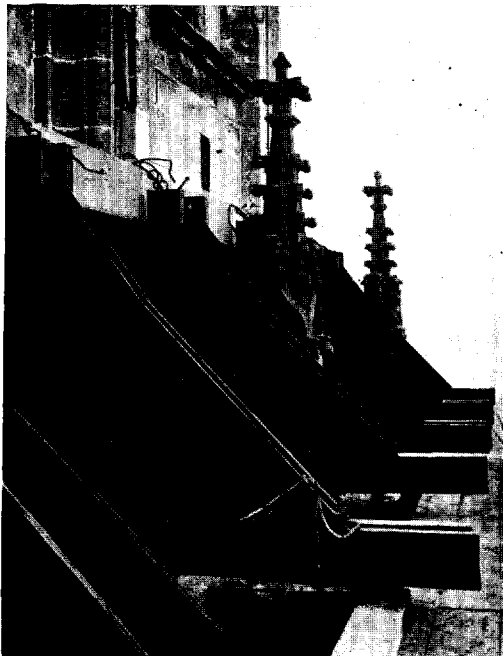
Afb. 22. IJzeren jukken die de steiger dragen.
