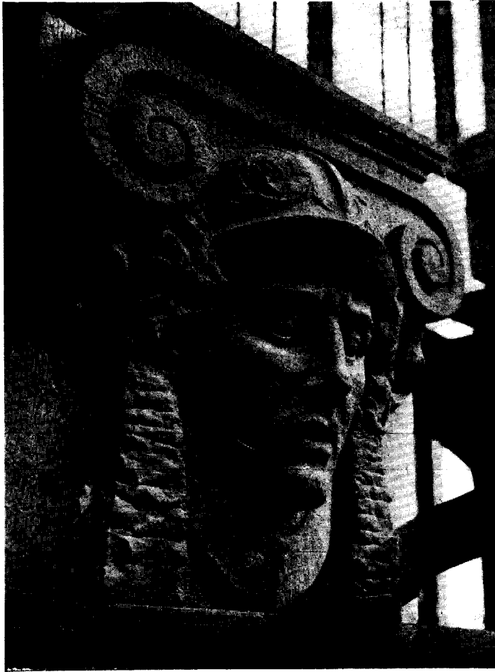
Afb. 11. „Aangekapte” kop (fase vóór de eindafwerking) bewerkt met spitsijzer en tandbeitel.
