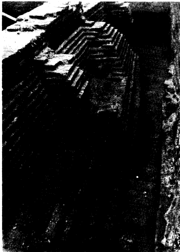
Afb. 12. Zuidmuur van de oudste bouwperiodes van het Enskerke op de Zuidpunt van Schokland, gezien uit het Zuid-Westen. Van achter naar voren: bouwfase 2, waarvan een beertje en een stuk muur te zien zijn; de zware uitspringende fundering van fase 3 en fase 4 is daarop gemetseld.
