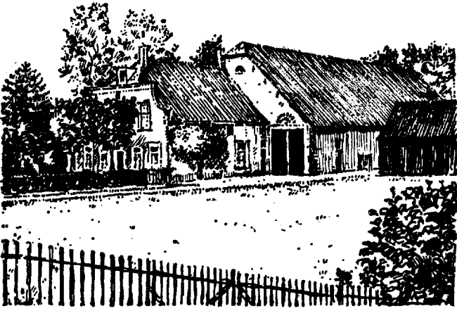
Afb. 3. Boerderij van de Zuidhollandse eilanden, 19e eeuw. De deel ligt in de lengterichting van de schuur en bij dit late type langs de buitengevel.
