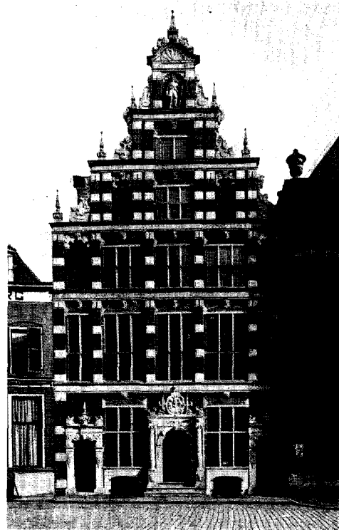
Afb. 11. Landshuis na de restauratie (Foto H. Roosdorp)
