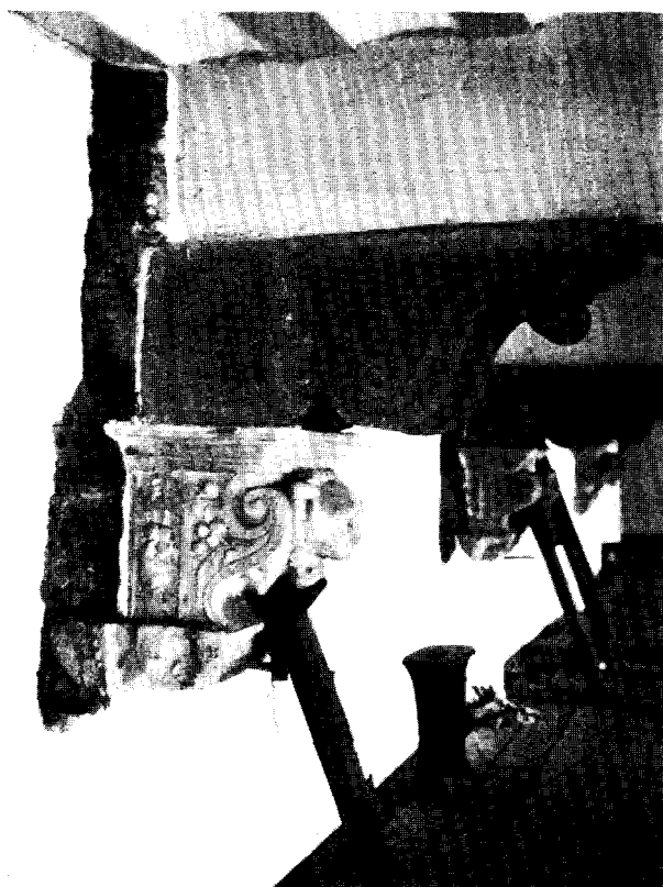
Afb. 11. Detail oplegging moerbinten Groot-Auditorium
