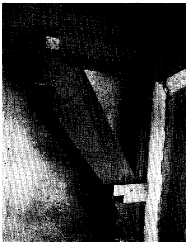
Afb. 13. Kapconstructie 1617, boven plafond Senaatskamer
