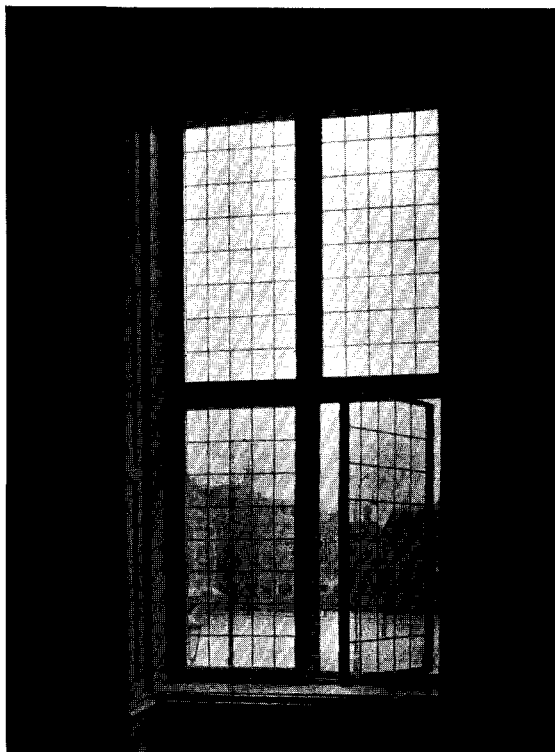
Afb. 11. Gerestaureerd raam hoofdverdieping met kruiskozijn, binnenaanzicht
