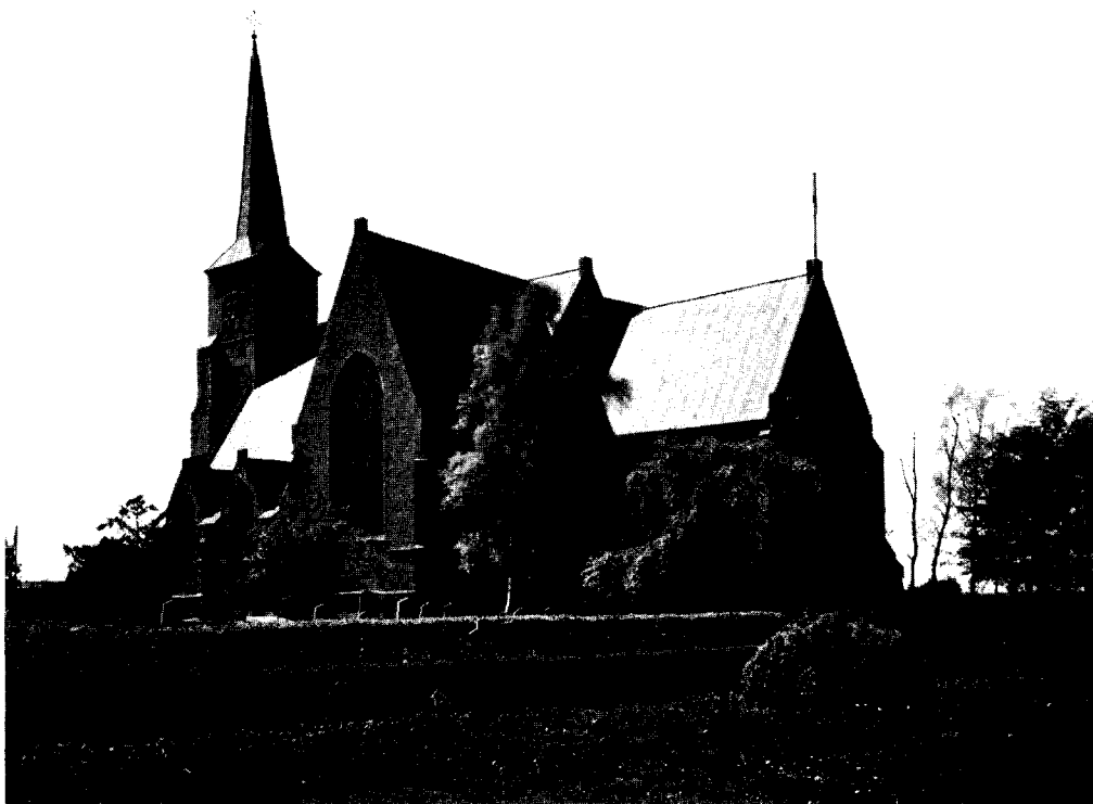
Afb. 4. Dezelfde Kerk na de restauratie
