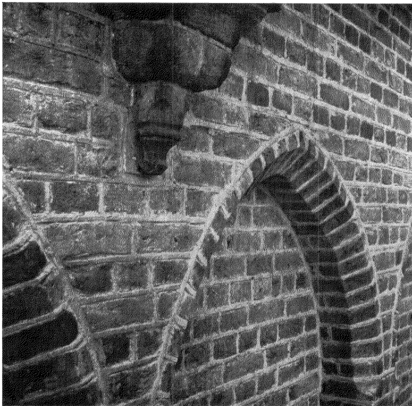
Gesneden voegen in den Noordgevel van de N.H. Kerk te Naaldwijk. (foto Rijksbureau voor de Monumentenzorg)
