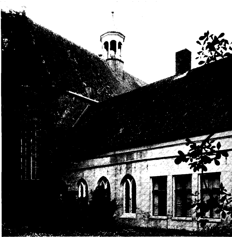
Afb. 3. Ter Apel; Oostvleugel en kerk voor de restauratie (foto bureau Mulder).
