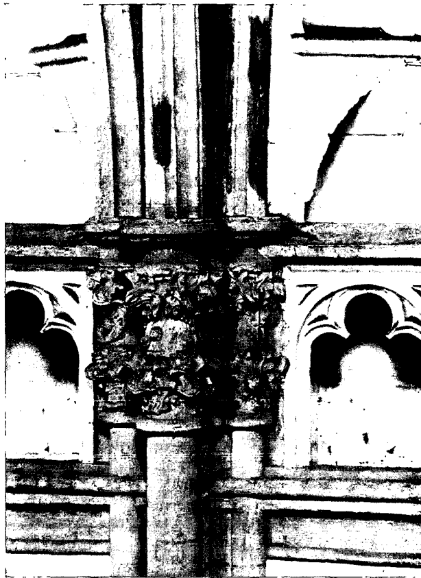
Afb. 15. Kapiteel in den middenbeuk, aan de Zuidzijde, tegelijk met de balustrade van het triforium uitgevoerd. Foto Rijksbureau voor de Monumentenzorg.
