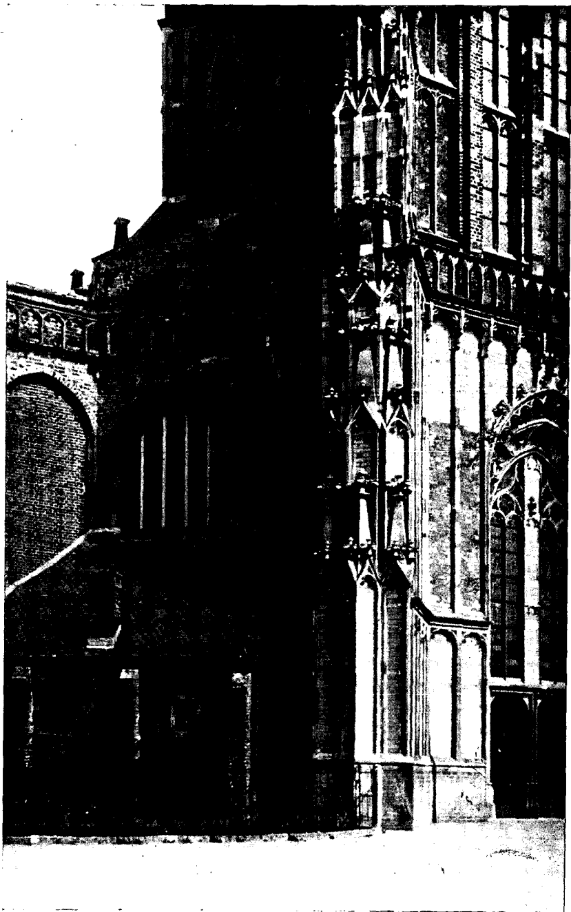
Afb. 16. N. W. Contrefort van den toren. Foto Ir. W. Voerman.
