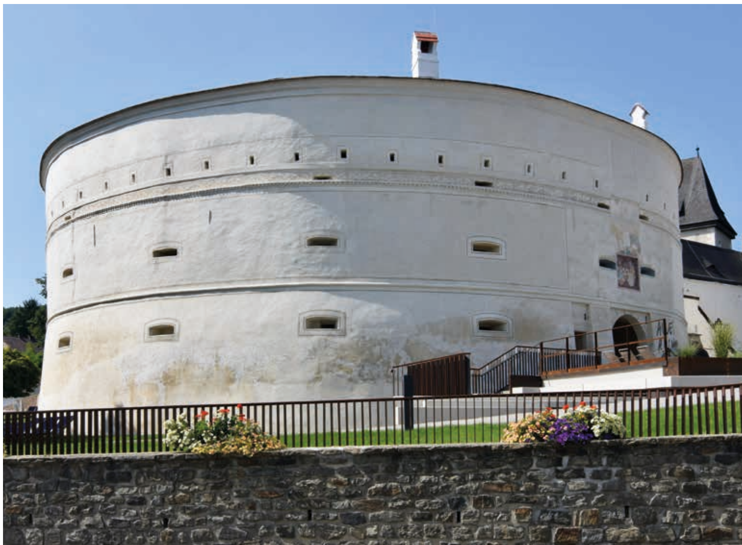
12. Barbacane kasteel Pöggstall, Oostenrijk, 1530-1540 (foto auteur, 2017)
