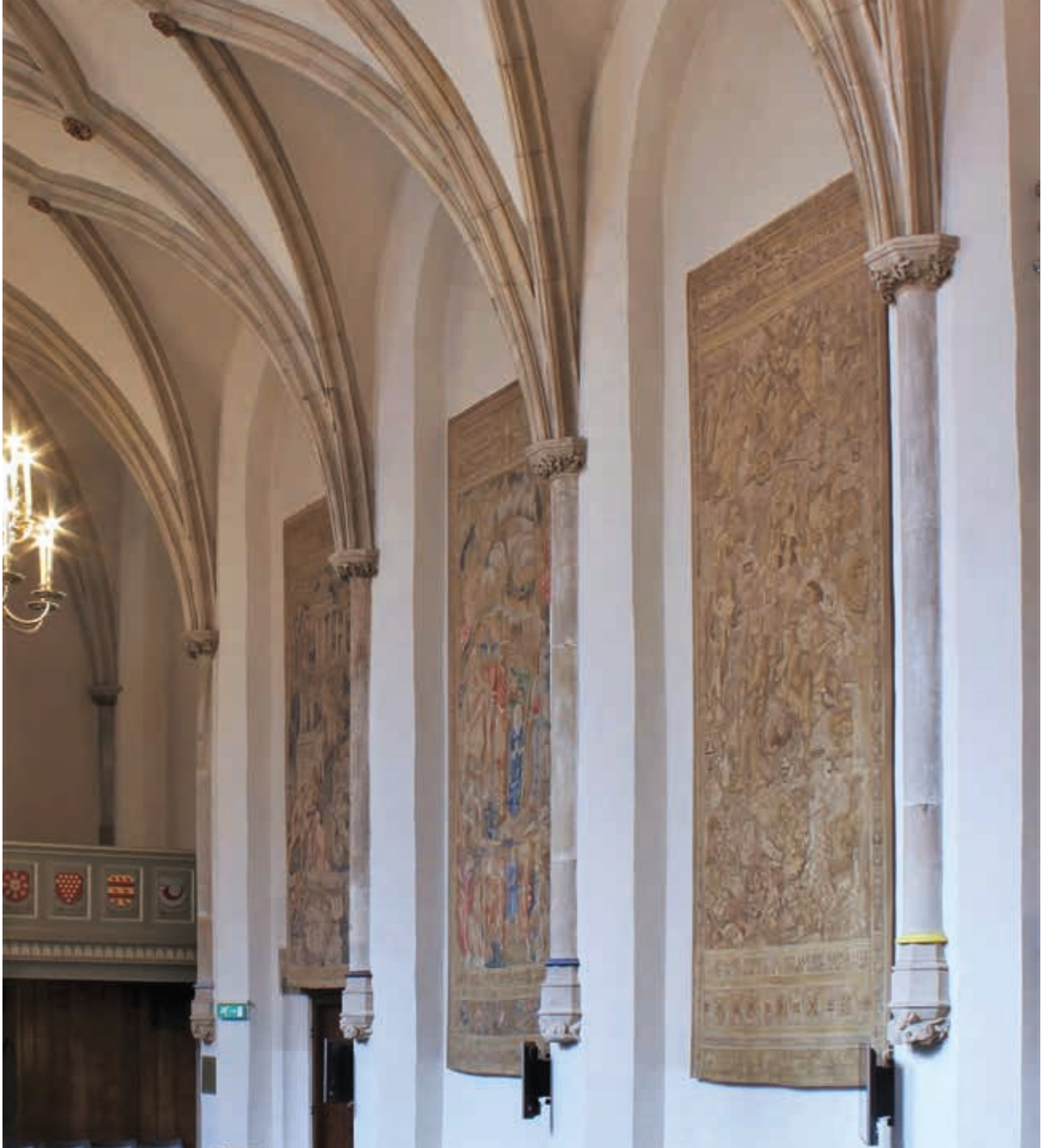
7. Noordelijke wand van het grote kapittelhuis van de Dom (thans aula van de Universiteit Utrecht) met de aanzet van het in 1495 verhoogde gewelf, rustend op schalken met basementen en kraagstenen (foto auteur)
