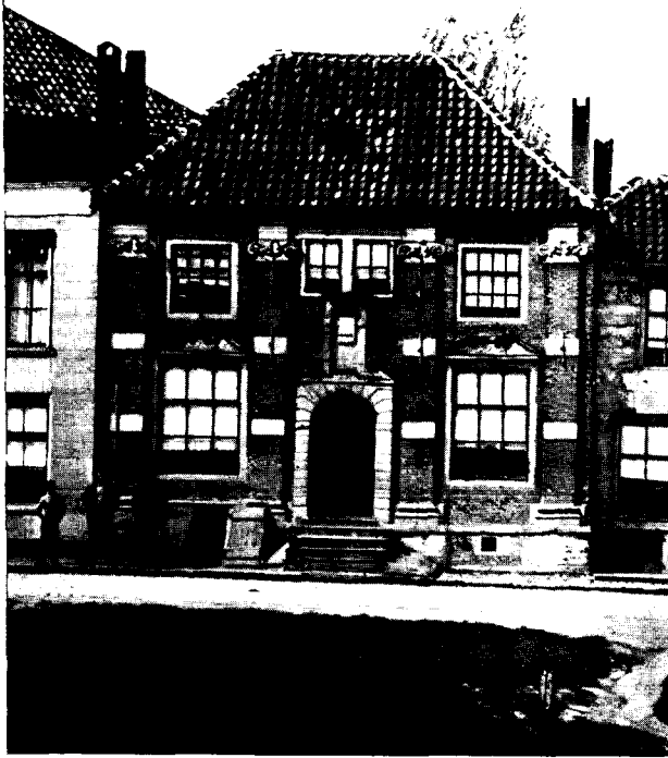
Afb. 12. Het zoogenaamde Brugwachtershuis te Goes.
