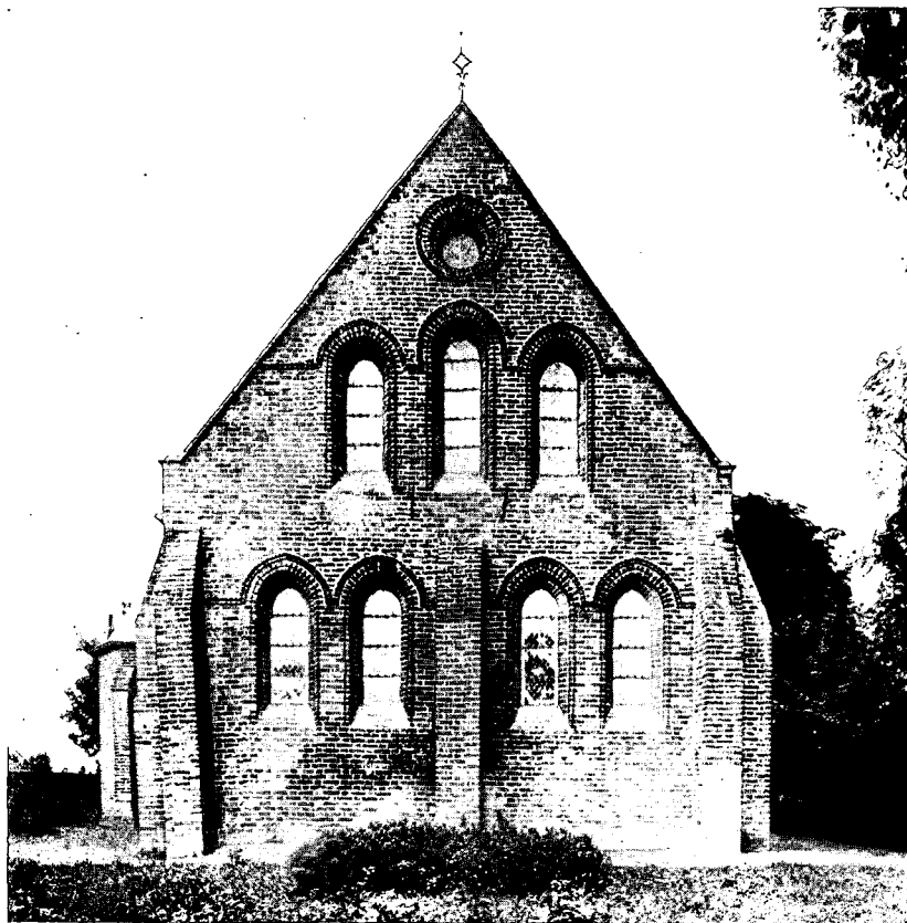
Afb. 18. N. H. Kerk te Kloosterzande uit het Oosten gezien.
