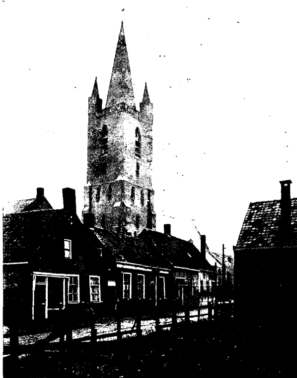
Afb. 3. Gemeentetoren en N. H. Kerk te Kapelle. Na de restauratie, gezien uit Noord-Westen.
