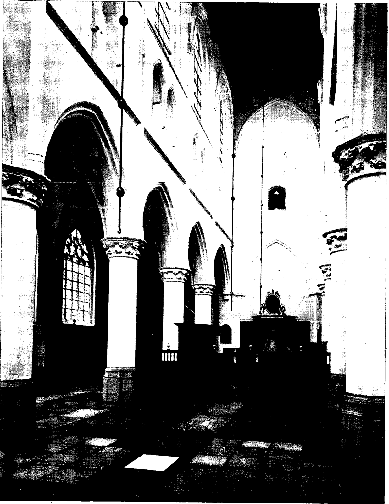
Afb. 13. Grote of S. Willibrorduskerk te Hulst. Middenschip (N. H. gedeelte) gezien naar het Oosten.
