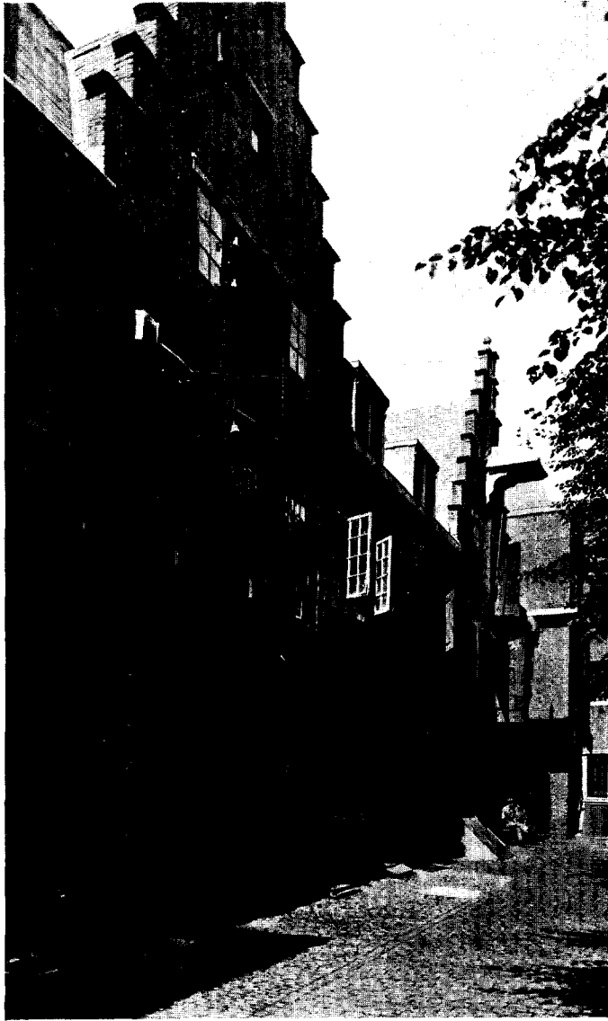
Afb. 24. Pakhuizen aan de tweede binnenplaats van het O. I. huis te Middelburg.
