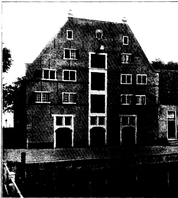
Afb. 56. Peperhuis te Enkhuizen, achtergevel aan het water.
