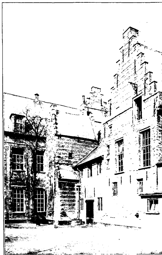
Afb. 47. Exercitieplaats met de achtergevels der gebouwen aan de eerste binnenplaats rechts, en het jongste gedeelte van het Markiezenhof links.
