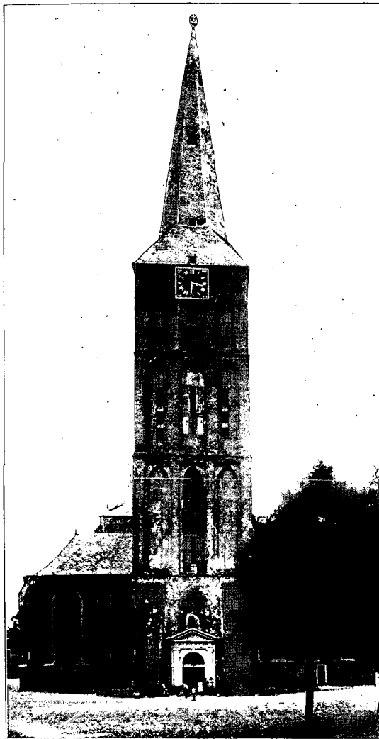
Afb. 6. Westgevel en toren.
