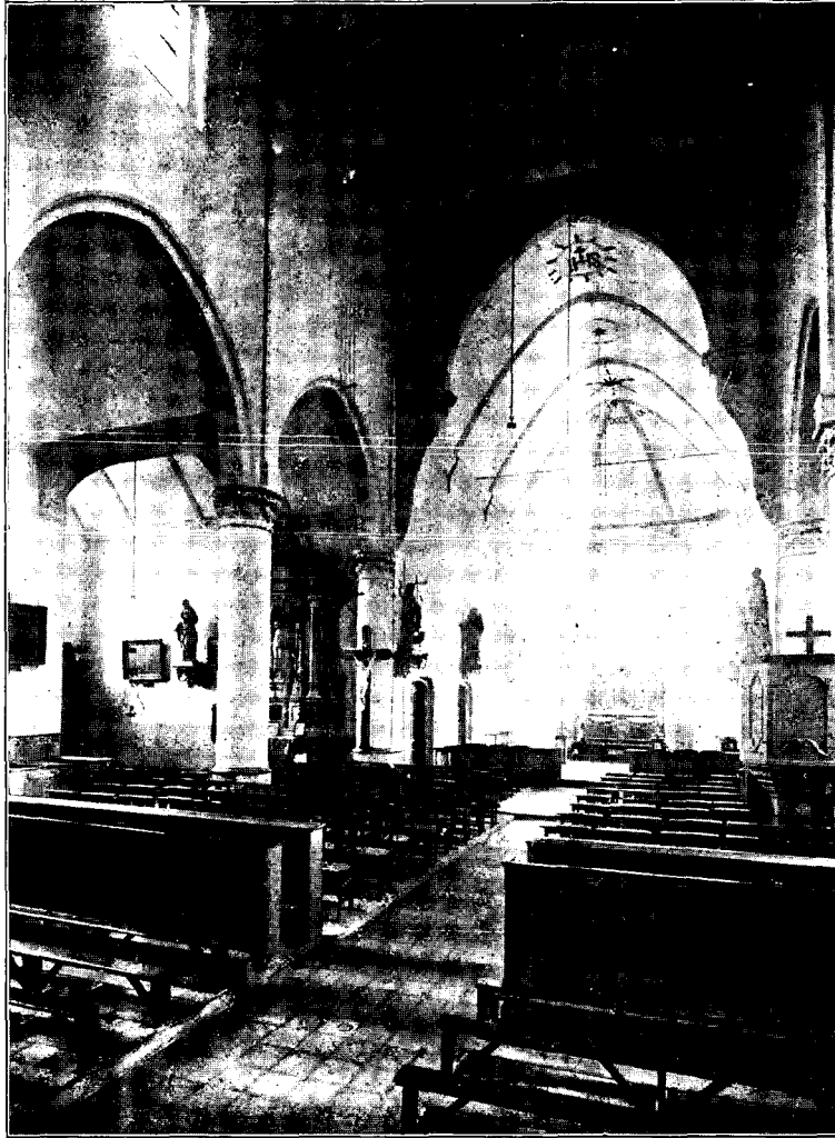
Afb. 82. Gezicht in de R.K. Kerk te Halsteren vóór de ontruiming. Foto Rijksbureau voor Monumentenzorg 1924.
