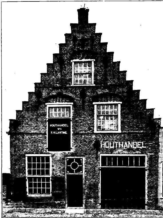
Afb. 98. Gevel Vischstraat No. 30, hoek Haven. Foto Rijksbureau voor Monumentenzorg 1924.
