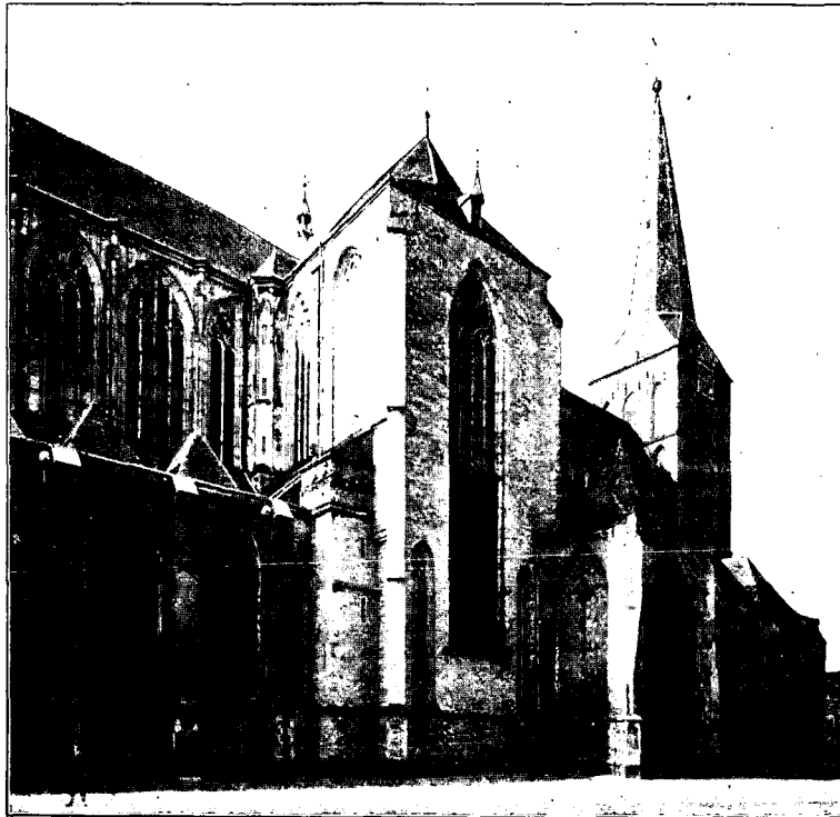
Afb. 4. Noordgevel en Dwarspand.
