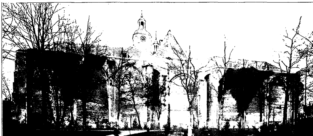
Afb. 27. Gezicht op den oostgevel der kerk.
