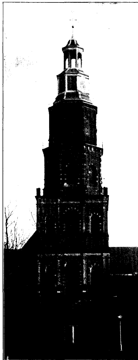
Fig. 3. De toren in den toestand vóór 10 Augustus 1911, gezien van het W.
