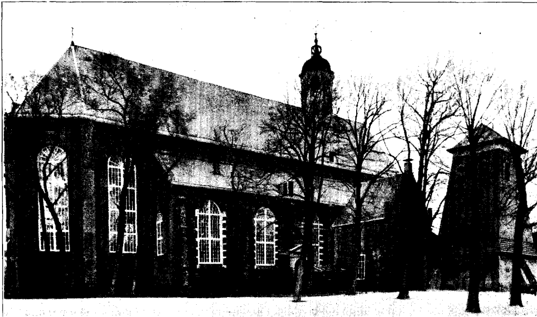
Afb. 5. De Nederl. Herv. Kerk, Sacristie en Klokkentoren.
