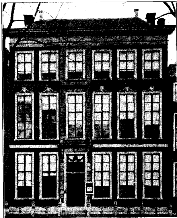
32. Gevel Haven N.Z. A. 344 (Arr. Rechtbank).
