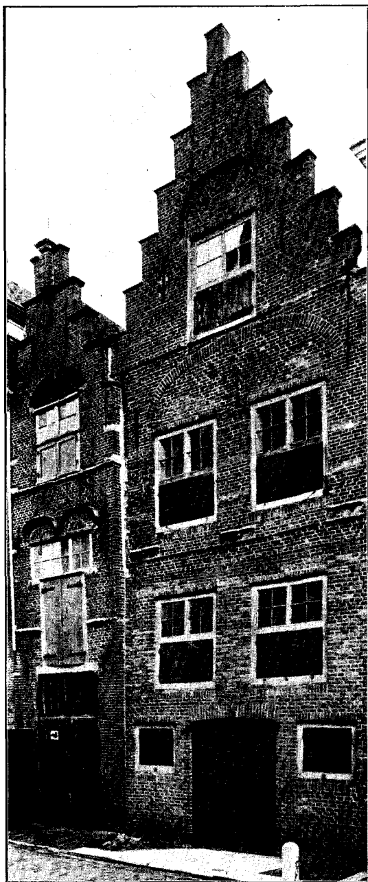
28. Gevel Meelstraat B 71.
