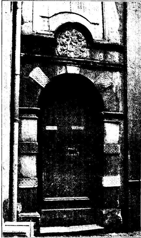
Deuromlijsting in steen, Snijderstraat, A o . 1643.
