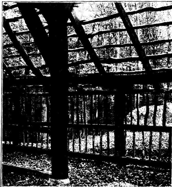
Fig. 5. Het Saksisch boerenhuis in aanbouw.
