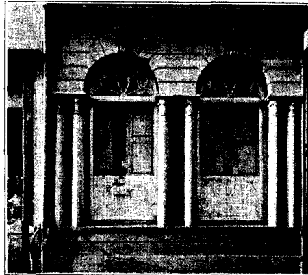
Afb. 33. Onderpui van een afgebroken gevel aan het Oude Delft te Delft.
