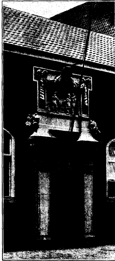
Afb. 13. Ingang der voormalige Saaihal in het Prinsenhof te Delft.
