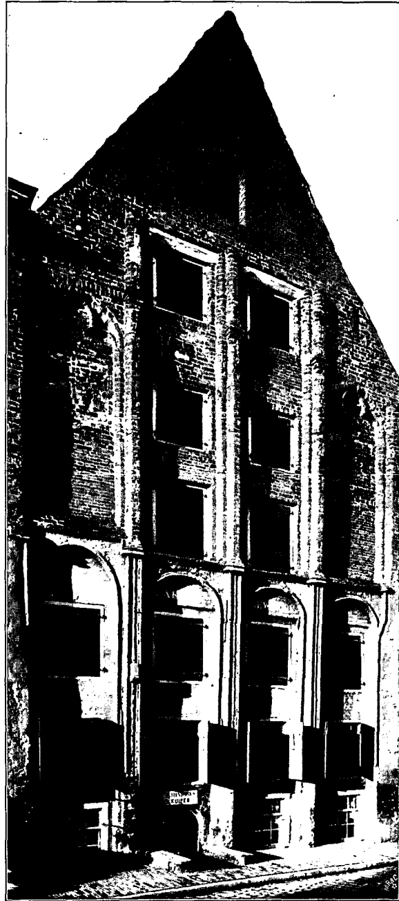
Afb. 23. De oude baksteenen gevel in de Brug-sstraat.
